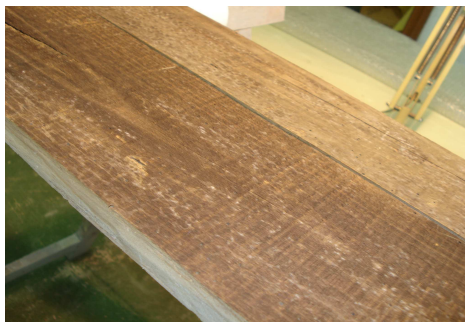
Figura IV. 17 Manchas brancas no provete COP1, antes do ensaio do painel radiante
