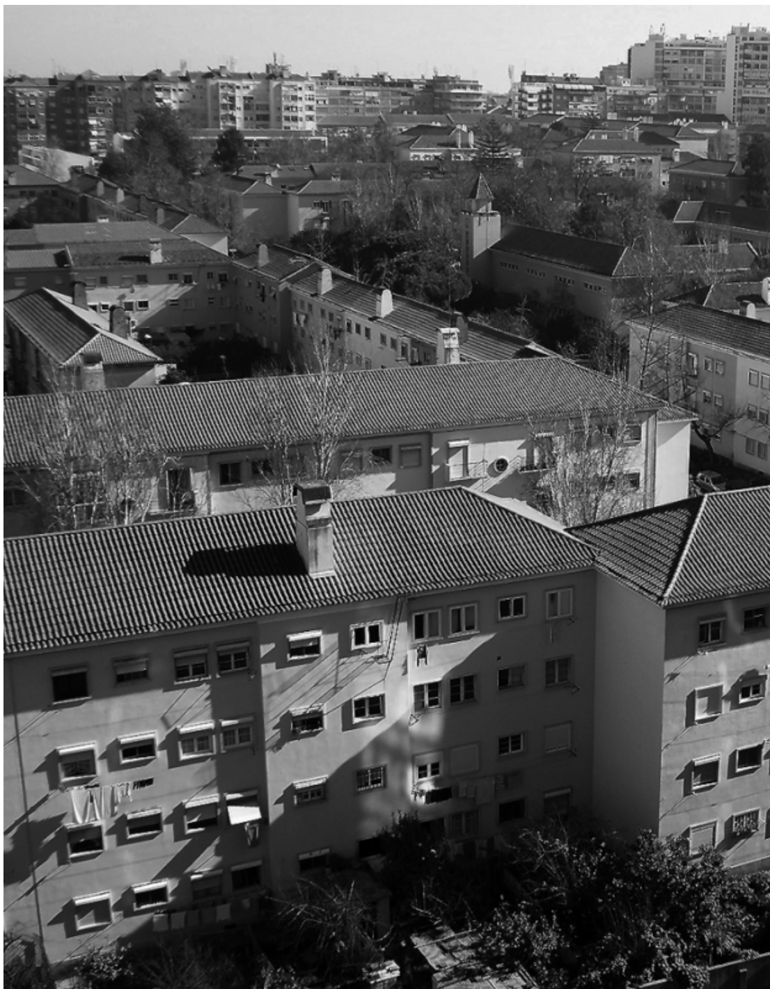
Fig. 01: Um espaço urbano acolhedor, bem habitado e desenhado - Vista parcial das "células" de habitação de interesse social que integram o "miolo" do Bairro de Alvalade em Lisboa, que teve projecto urbano do Arq.º Faria da Costa, realizado durante os anos 40 e 50 do século passado.
