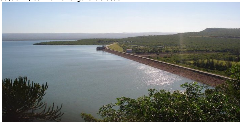
Figura 1 - Vista de montante da barragem dos Pequenos Libombos
