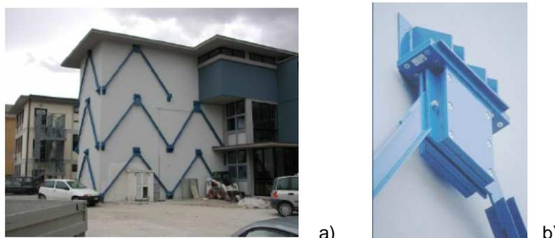
Figura 62 – Edifício Gentile Fermi, Fabriano, Itália: a) vista geral do exterior e b) detalhe de dispositivo colocado [Antonucci, 2001]
