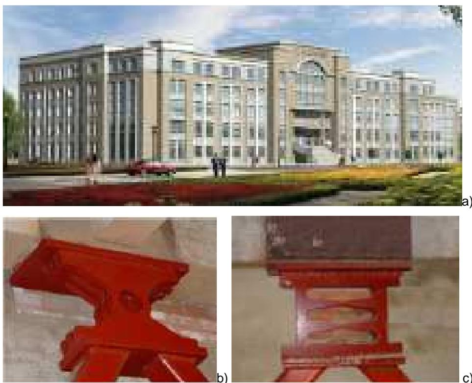
Figura 52 - Edifício em betão armado na Dalian University of Technology, China: a) vista geral do exterior, b) dispositivo com orifício circular simples colocado e c) dispositivo com orifício em forma de X duplo colocado [Li e Li, 2007].
