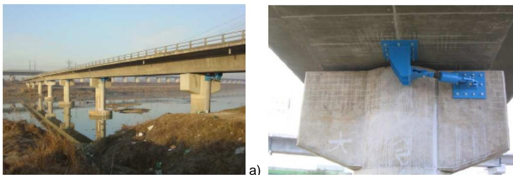
Figura 78 – Ponte Dong-Yu, Korea: a) vista geral da estrutura e b) detalhe de colocação de dispositivo na direcção transversal [Infanti et. al, 2004]
