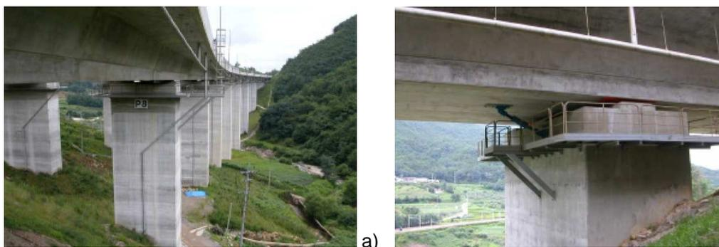
Figura 74 – Ponte Seohae, Seoul, Korea: a) visão geral da estrutura e b) detalhe de colocação do dispositivo [Infanti et. al, 2004]
