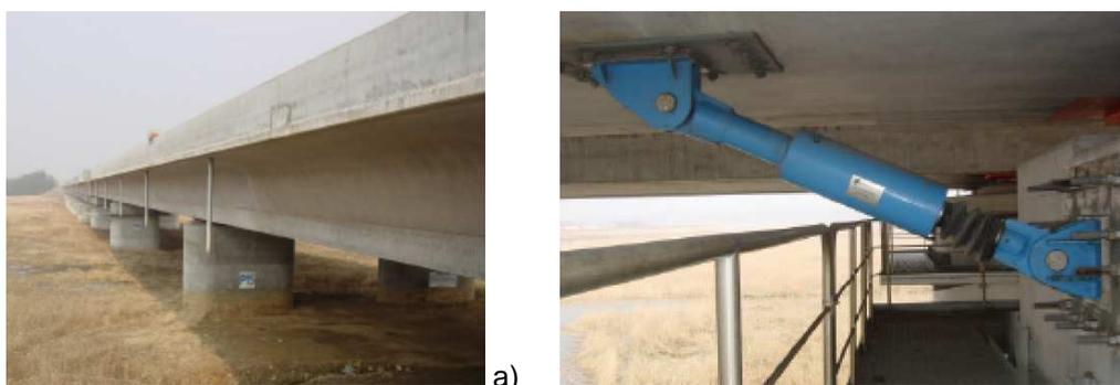
Figura 75 – Ponte Chun-Su, Korea: a) vista geral da estrutura e b) detalhe de colocação do dispositivo [Infanti et. al, 2004]
