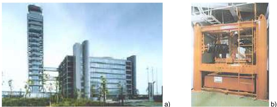
Figura 149 – Aeroporto Internacional de Kansai, Kansai, Japão: a) Visão global do exterior; b) unidade de amortecedor híbrido de massa colocada na torre de controlo de tráfego aéreo [Kareem et. al, 1999].
