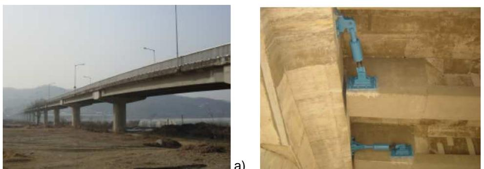
Figura 76 – Ponte E-Po, Korea: a) vista geral da estrutura e b) detalhe de colocação de dispositivos na direcção transversal e longitudinal [Infanti et. al, 2004]
