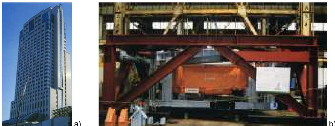
Figura 148 – Hotel RIGHA Royal, Japão: a) Vista global do exterior; b) unidade de amortecedor híbrido de massa instalado [Kareem et. al, 1999].
