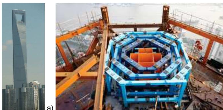
Figura 128 – Shanghai World Financial Center, Shanghai, Japão: a) Vista do exterior e b) detalhe construtivo do amortecedor activo de massa sintonizado [SWFC Wikipedia, 2009]
