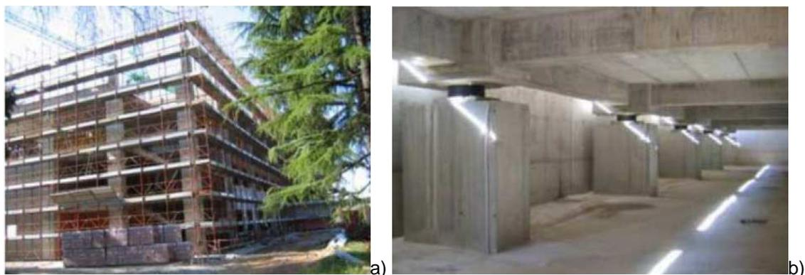
Figura 19 - Hospital Gervasutta, Itália: a) Aspecto geral, b) detalhe do posicionamento aparelhos de apoio HDRB [Dolce et. al, ...]
