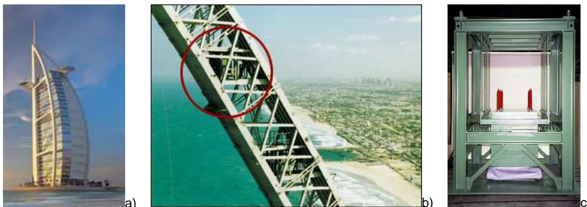
Figura 97 – Hotel Burj Al Arab, Dubai, Emirados Árabes Unidos: a) Vista global do exterior [BAA, 2009], b) pormenor de colocação do amortecedor de massa sintonizado [Gerb, 2009] e c) detalhe de amortecedor de massa sintonizado [Gerb, 2009]
