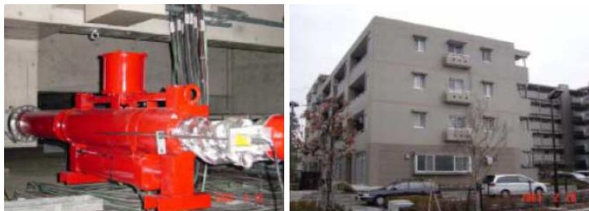
Figura 166 - Implementação de solução híbrida entre amortecedor de fluído controlável magnetoreológico e isolamento de base em estruturas de edifícios: a) detalhe do dispositivo colocado [Fujitani et. al, 2003] e b) exemplo de aplicação [Fujitani et. al, 2003]
