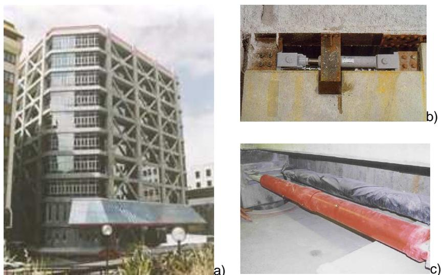
Figura 45 - Central de Polícia de Wellington, Nova Zelândia; a) Vista exterior [Robinson Seismic Lda, 2008]; b) e c) Detalhe dos Lead Extrusion Dampers colocados [Aiken, 2006]
