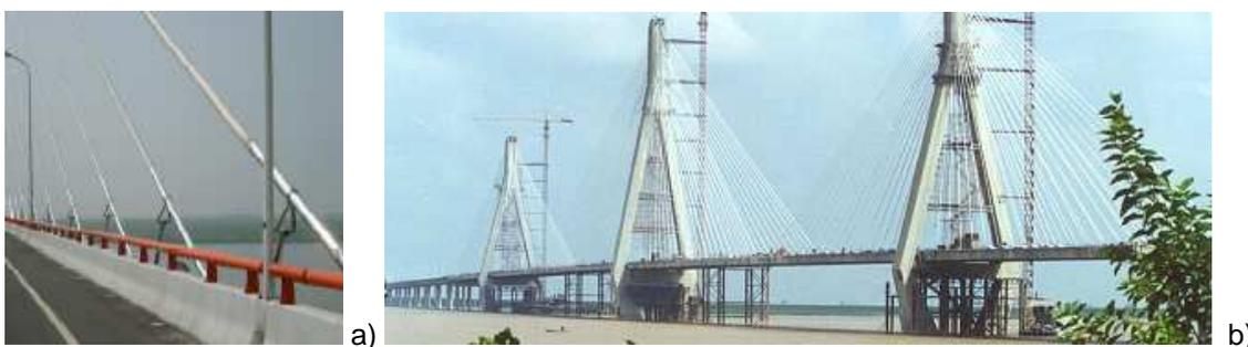
Figura 164 - Implementação de amortecedor de fluido controlável magnetoreológico em pontes: a) Detalhe do dispositivo colocado [DTL, 2009] e b) Ponte Dong Ting Lake, China [DTL, 2009]
