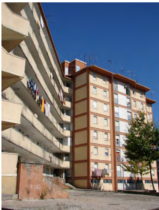
Figura 3.7 – Edifício no Bairro das Amendoeiras
