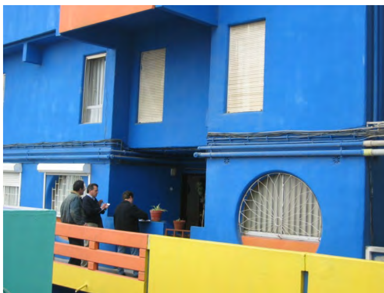
Figura 2.2 – Vistoria a locado no âmbito da aplicação experimental do MAEC
