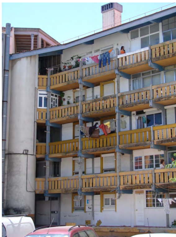
Figura 3.9 – Exemplo de um edifício vistoriado
