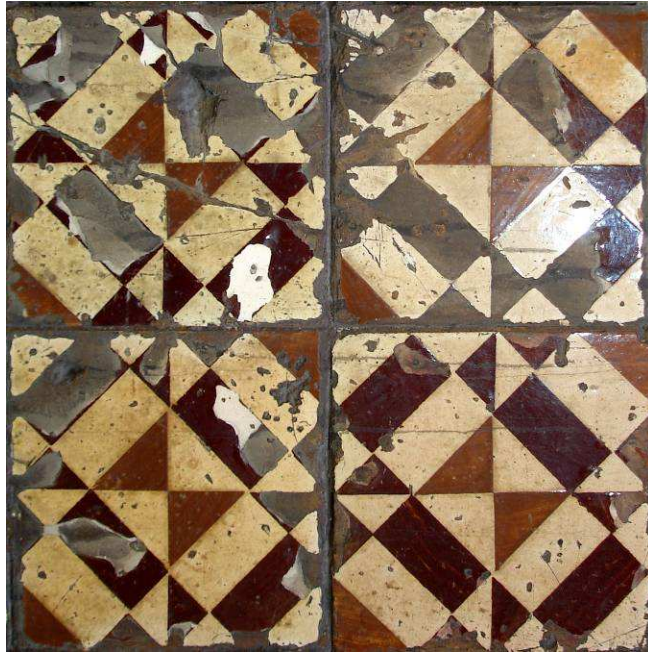
Figura 35- Queda do vidro afectando principalmente as áreas castanho-escuro (azulejos marcados da Fábrica das Devesas)
