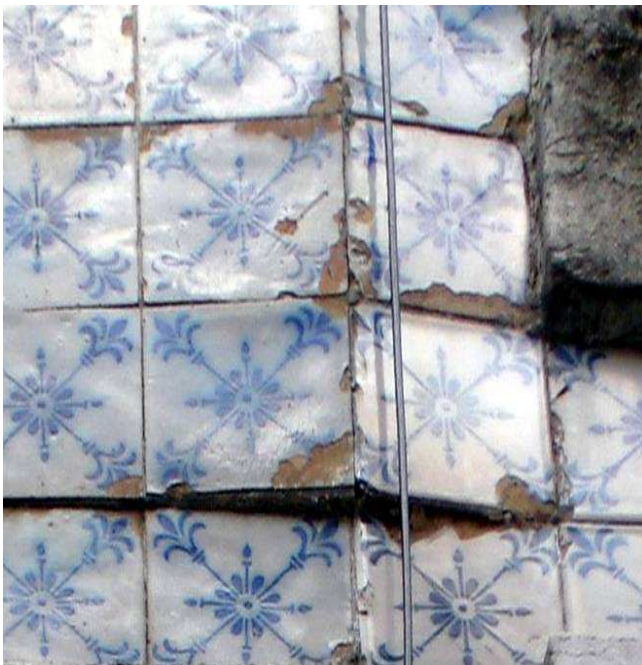
Figura 13- Instabilização de azulejos com formação de “barrigas” (13a- azulejos cerâmicos na Rua das Salgadeiras ao Bairro Alto; 13b- azulejos de pó de pedra na Rua da Alegria)
