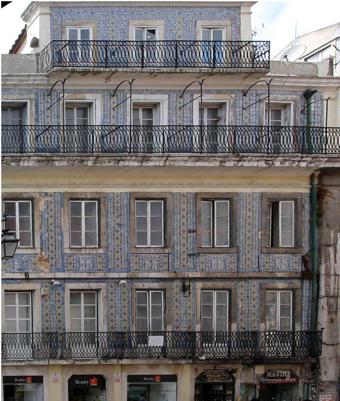
Figura 4- Fachada na Rua das Portas de Santo Antão com azulejamento arcaico 1
