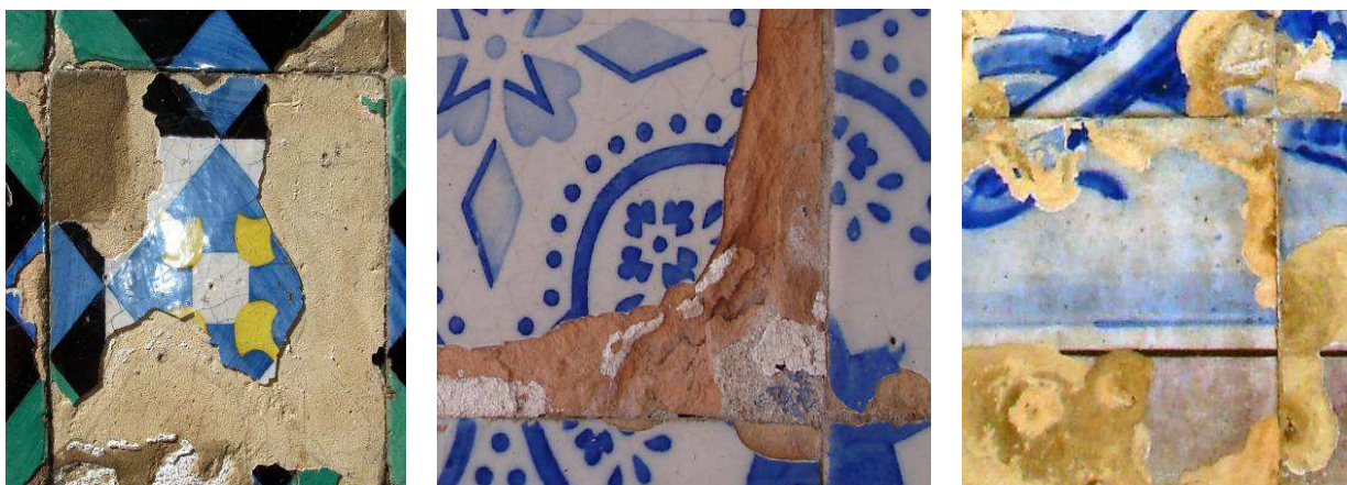
Figura 37a- Chacota lisa após a queda do vidrado comparada com chacotas em processo de desagregação em lâminas (figura 37b) ou por arenização mais ou menos fina (figura 37c) em casos em que pode também estar em curso uma alteração por cristalização de sais solúveis
