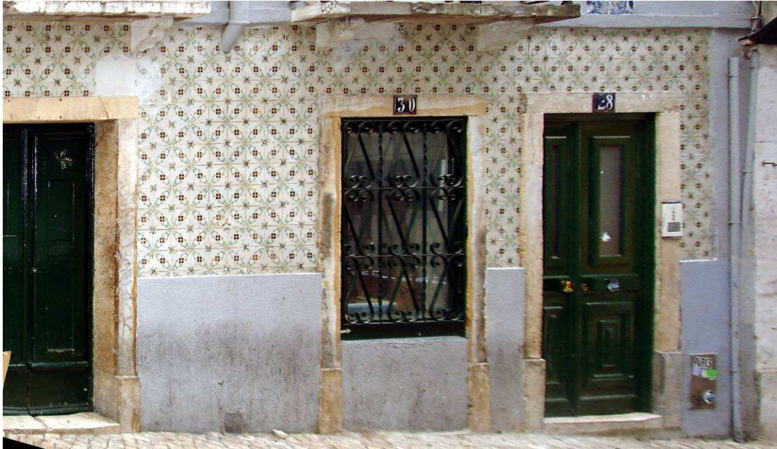
Figura 2a- Fachada na Rua do Diário de Notícias ao Bairro Alto com azulejos D. Maria (finais do séc.XVIII) aplicados em data desconhecida
