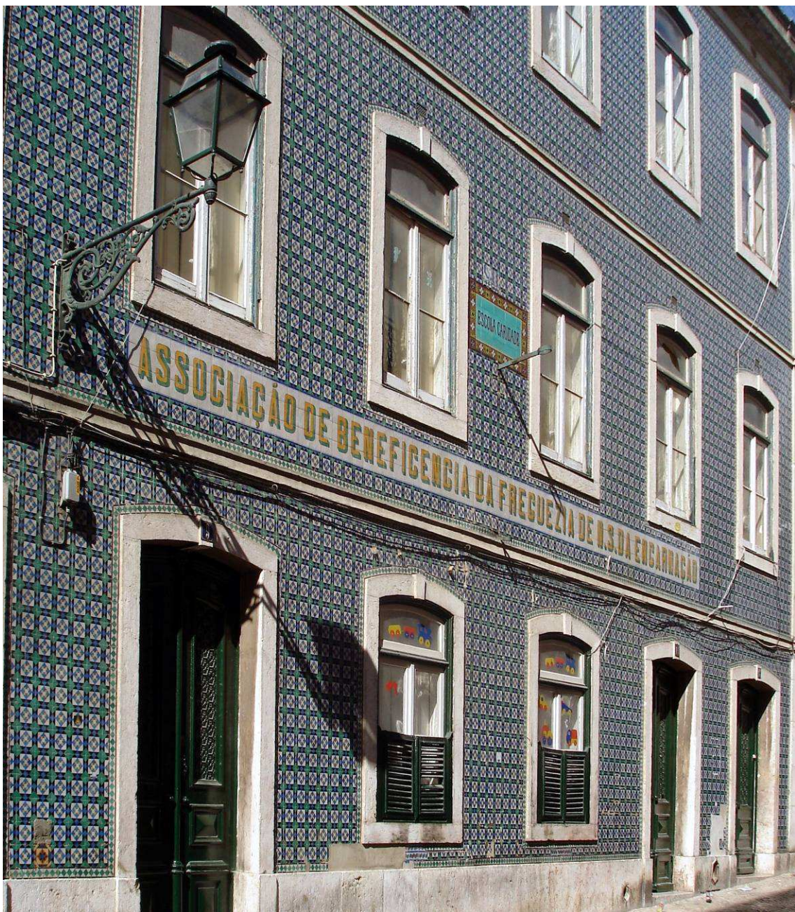
Figura 16- Edifício na Rua do Teixeira ao Bairro Alto, sem problemas de infiltrações pela fachada mas com humidade ascendente
