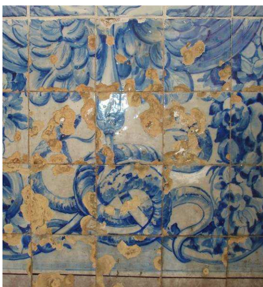
Figura 9a, b, c- Quedas de vidrado cujas morfologias características indiciam possíveis origens em diferentes níveis de agressão e defeitos de aderência
