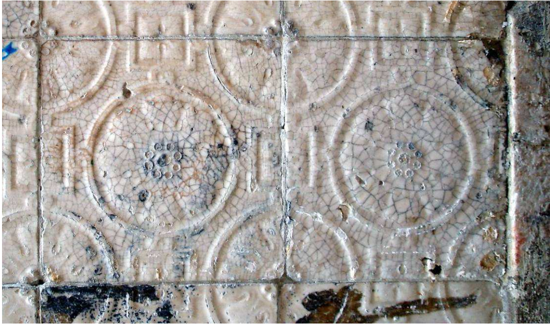
Figura 18- Craquelé em azulejos relevados em pó de pedra, atribuíveis à Fábrica de Sacavém (Rua do Poço da Cidade ao Bairro Alto)
