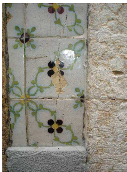
Figura 9a, b, c- Quedas de vidrado cujas morfologias características indiciam possíveis origens em diferentes níveis de agressão e defeitos de aderência
