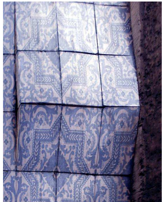
Figura 13- Instabilização de azulejos com formação de “barrigas” (13a- azulejos cerâmicos na Rua das Salgadeiras ao Bairro Alto; 13b- azulejos de pó de pedra na Rua da Alegria)
