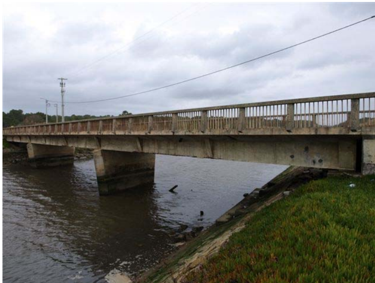
Figura 1. Vista de Sul para Norte da ponte em estudo.
