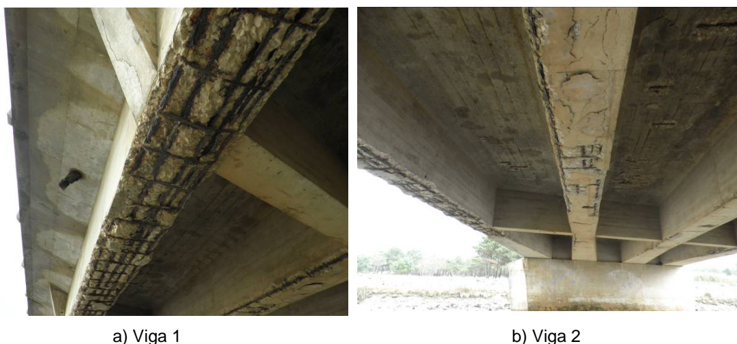
Figura 3. Vistas inferiores do tramo Sul da ponte.
