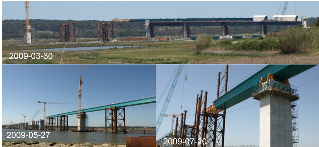
Figura 2. Lançamento incremental do tabuleiro.
