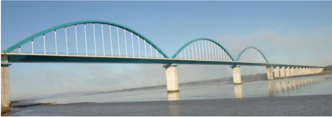
Figura 1. Vista geral da ponte sobre o rio Sado.
