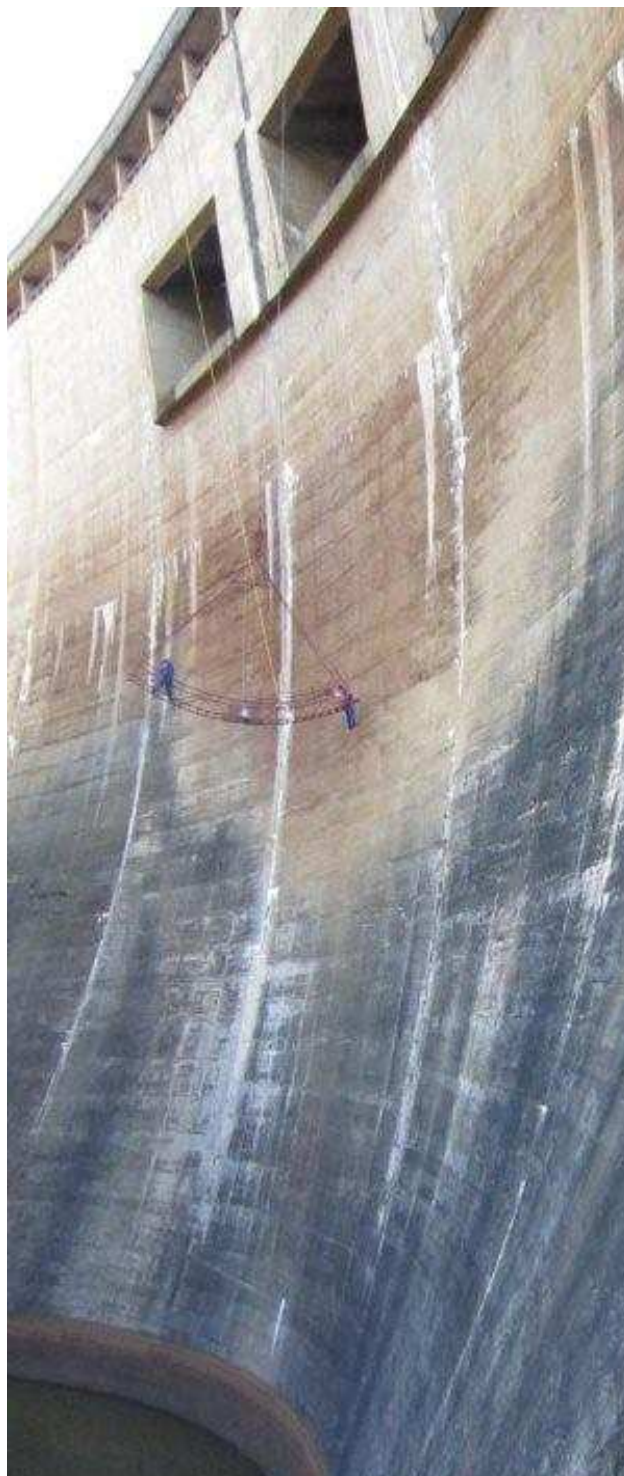
Fig. 8 – Aspecto do cesto metálico, suspenso do coroamento, utilizado para a instalação dos alvos geodésicos no paramento de jusante
