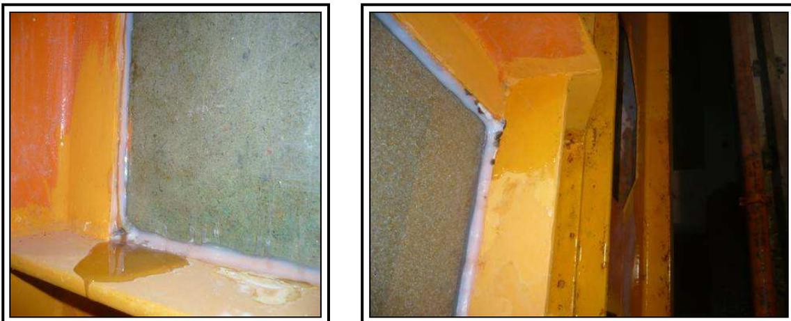
**Figura 6 – Aspectos das infiltrações junto aos vidros do canal**
