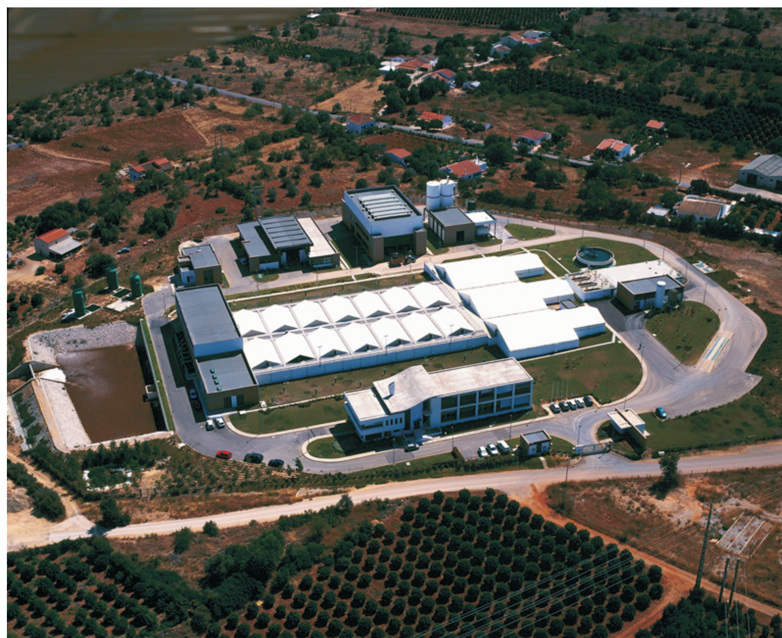
Figura 1- Vista aérea da Estação de Tratamento de Água de Alcantarilha
