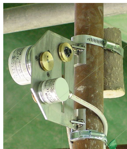
Fig 9b - Suporte dos encoders . Pormenor da fixação à estrutura
