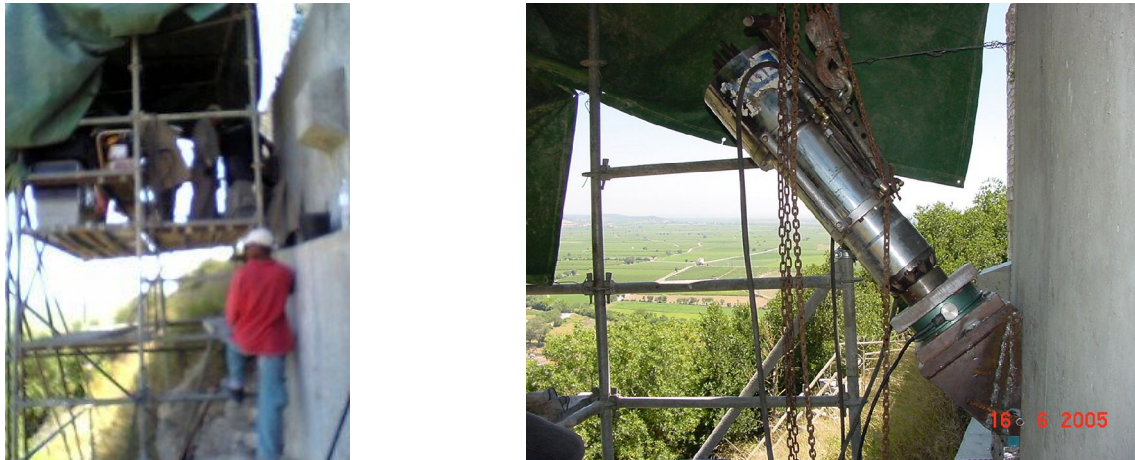
Fig. 2 – Exemplo de plataforma de suporte ao ensaio de uma ancoragem (Santarém).
