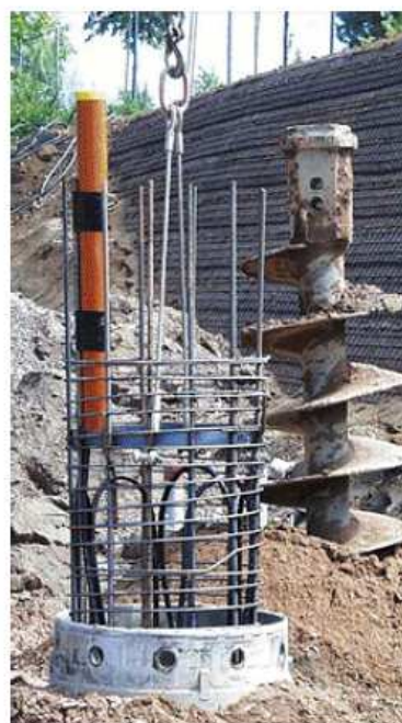
Figura 3 – Pormenor de construção de uma estaca energética
