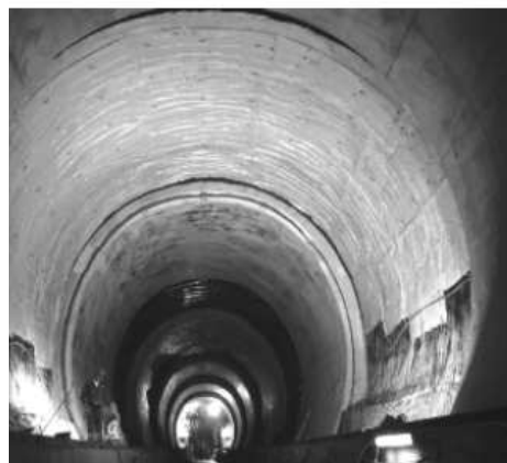
Figura 6 – Geotêxtil energético no túnel LT22 (Adam e Markiewicz, 2009)
