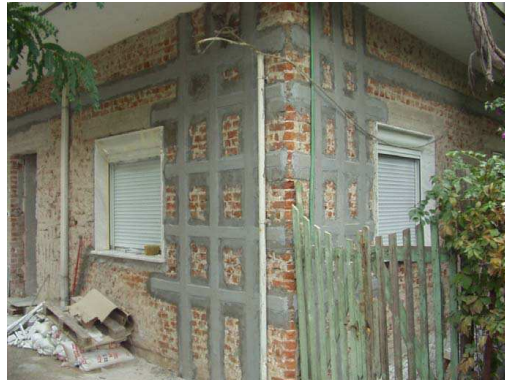
Figura 5: Exemplo de aplicação de FRP numa parede de alvenaria (Catálogo “Sika Carbodur FRP Composites”)
