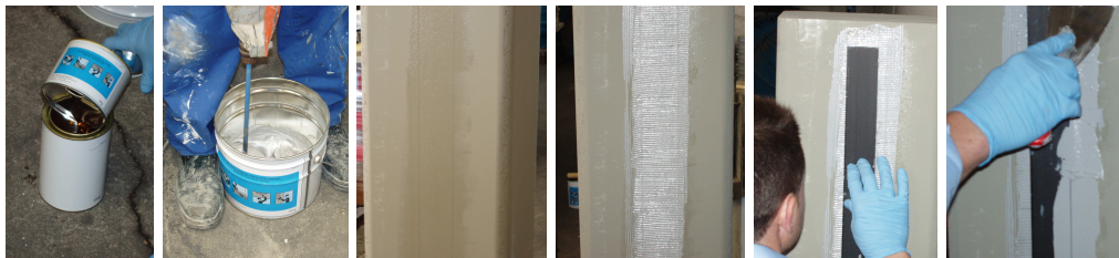
Figura 2: Aplicação de um sistema pré-fabricado de FRP
