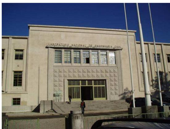
Fig. 4 – Revestimento exterior de marmorite de clã do edifício principal do LNEC (Lisboa, 1952)
