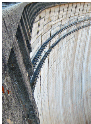
Figura 7 – Vista da zona superior da barragem.
