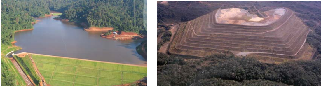
Figura 1 – Barragem de Contenção de Rejeitados e Empilhamento Drenado de Rejeitado Granular
