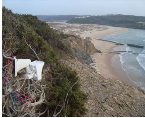
Figura 25 – Instalação da câmara de vídeo-monitorização
