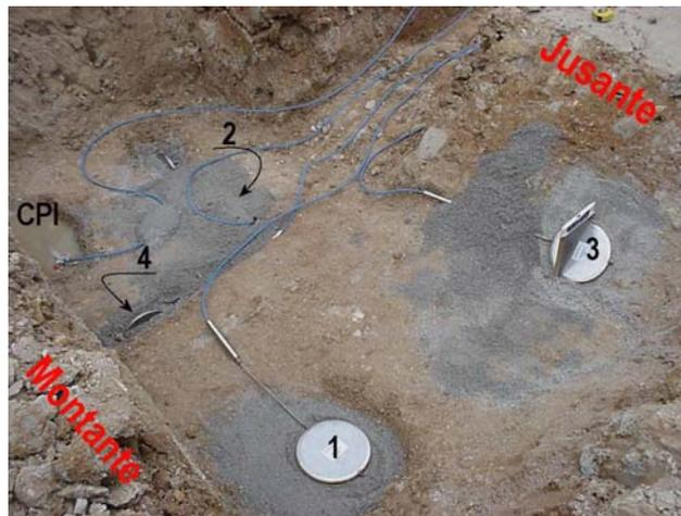
Figura 5 - Aspecto da montagem de um grupo de células de tensão total
