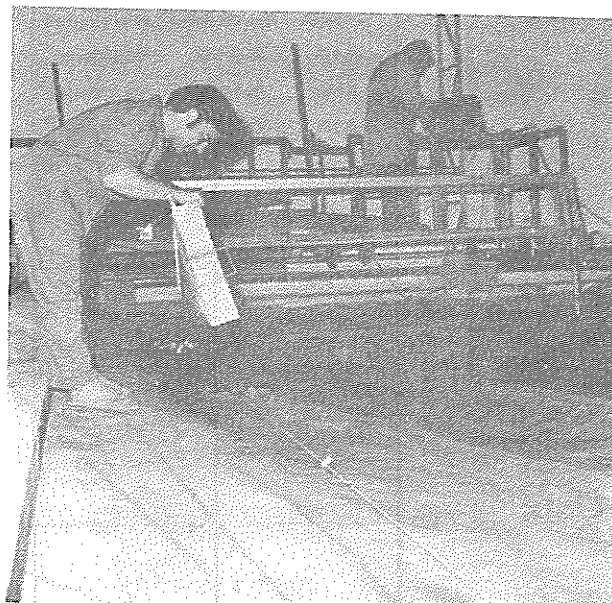
FIG. 48 - Acumulação de material móvel na extremidade B da praia e operação manual de alimentação.
