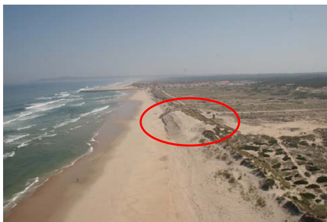
Figura 1. Vista aérea, com a Leirosa ao fundo, da câmara de carga do emissário e do trecho da duna em frente à câmara de carga (a vermelho) que foi parcialmente reabilitada, TEN VOORDE et al. (2006).
