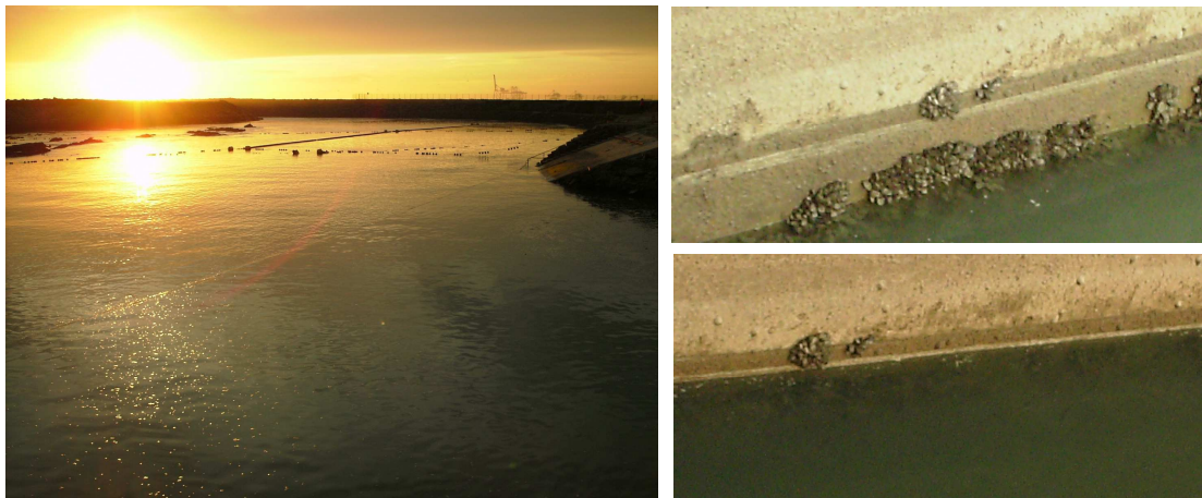
Figura 5: Bacia de adução de Sines durante um evento ressonante e aspecto da variação de nível no interior da bacia devido a ondas de longo período.
