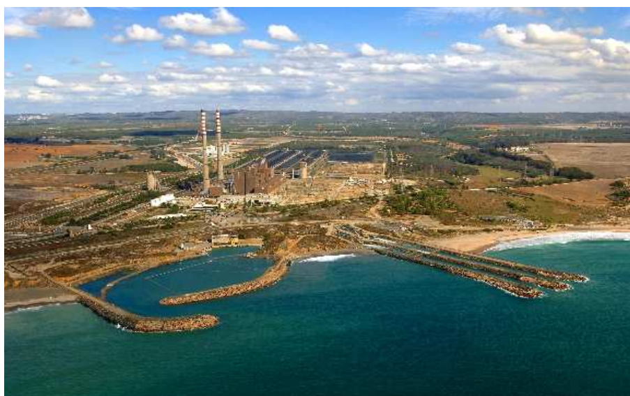
Figura 1: Vista aérea da bacia de adução da central termoeléctrica de Sines.
