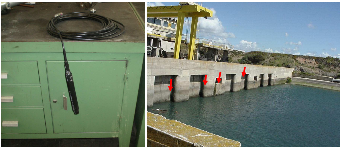
Figura 2: Sensor de pressão hidrostática e respectiva localização na bacia de adução.
