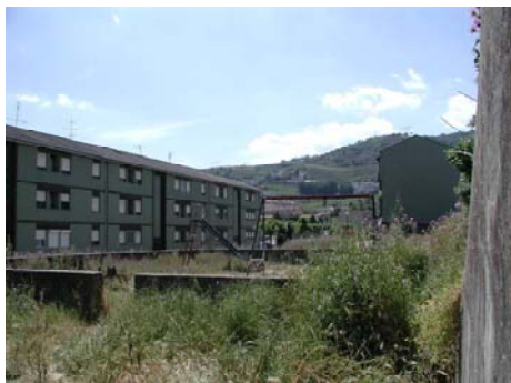
Figura 4. ALAGOAS | Antes da intervenção
