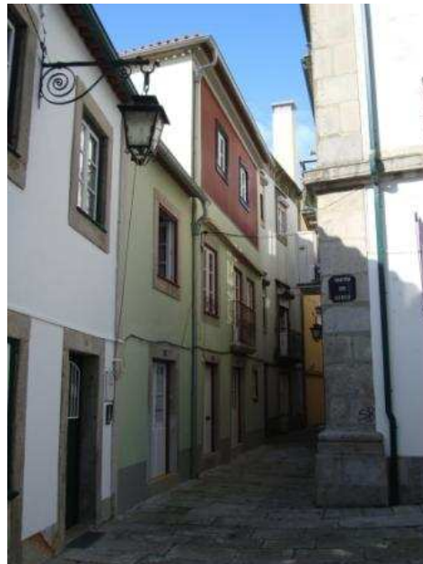
Fig. 03: a reabilitação de edifícios que integram a continuidade de zonas urbanas centrais, constitui uma dupla medida de revitalização dessas zonas e de se proporcionar aos respectivos habitantes um meio urbano coeso e uma vizinhança bem equipada; na imagem uma intervenção desse tipo na Rua de São Pedro em Viana do Castelo, 2008, promovida por um particular com apoio da respectiva C. M. e projecto do Arq.º José Loureiro.
