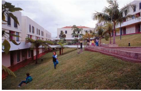
Figura 05: (1988) Madalena, Funchal, Coop. Coohafal, Arq. Guilherme Barreiros Salvador, 100 habitações – e um exemplo de como é possível fazer um conjunto onde interiores e exteriores constituem uma unidade de uso e neste caso de recreio (acontecia um aniversário).
