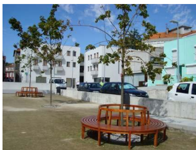
Figura 10: (2007) Câmara Municipal do Porto, Fontainhas, Arq.os Helder Ribeiro e Amândio Cupido, 21 habitações – cada vez mais as novas intervenções residenciais devem integrar-se harmonicamente na cidade e na paisagem, valorizando-as e preenchendo, requalificando e dando coesão a espaços anteriormente abandonados ou degradados, enquanto se proporciona uma integração “de grão fino”, e portanto facilitada, dos novos habitantes; neste caso, numa zona central e tradicional do Porto, 21 novas
