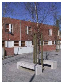
Figura 11: (2002) Câmara Municipal de Matosinhos, Telheiro, Arq.º Manuel Correia Fernandes, 44 habitações – naturalmente que no fazer habitação e cidade com interesse social, portanto com adequação a quem habita e valia urbana, é essencial desenhar pormenorizadamente o habitar interior, exterior e de relação; e aqui encontramos mais uma daquelas verdades que parecem ser óbvias, mas que exigem constante atenção, pois muito se ganha ou se perde na pormenorização e o bom desenho é aquele que resulta de uma prolongada retroacção entre pormenor e aspectos mais gerais ou estruturadores, e este pequeno “bairro” do Telheiro, do Prof. e membro do Grupo Habitar Manuel Correia Fernandes é um “tratado” de bom e sóbrio desenho.
