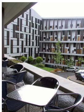
Figura 04: (2006) Funchal, Imopro, Arq. a Carla Baptista e Arq. Freddy Ferreira César, 350 habitações – mais um exemplo de como fazer habitação e cidade de interesse social, numa intervenção estratégica e cuidadosamente densificada, bem habitada, viva e desenhada ( e pessoas de outros conjuntos de habitação de interesse social querem mudar para aqui, quando há vagas).
