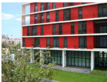
Figura 09: (2007) Câmara Municipal de Oeiras, Carnaxide, habitação apoiada para pessoas acamadas e idosos, Arq.os Cristina Veríssimo, Diogo Burnay e Patrícia Ribeiro, 45 unidades habitacionais – é tempo da habitação de interesse social se dedicar, também, e de forma efectiva a novas formas de habitar consistentes e motivadoras, como acontece neste recente exemplo que associa zonas de convívio e de serviços comuns (piso térreo), quartos com zonas de estar para pessoas acamadas (1.º andar) e pequenos apartamentos com um quarto (do 2.º ao 4º andares).
