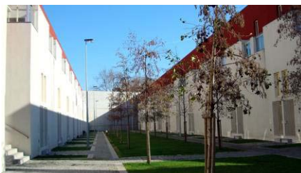
Figura 02: (2006) Cooperativa Águas Férreas, Bairro da Bouça, Porto, Arqs. Siza Vieira e António Madureira – a reabilitação e a completção de um conjunto habitacional paredes meias com uma linha de metro ligeiro, que vitaliza o centro da cidade e que parece servir bem diversos grupos socioculturais; e naturalmente há sempre a questão da qualidade do desenho, como tributo a cada habitante e à cidade.
