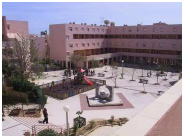
Fig. 02: o miolo do quarteirão equipado da cooperativa Coobital, Alto de St. António, Faro, do Arq. Lopes da Costa.
