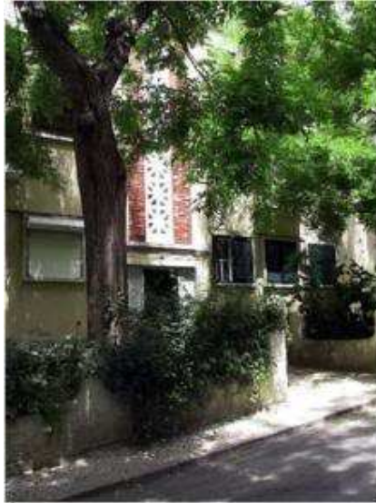
Fig. 08, um pormenor do denso, agradavelmente contínuo e apropriável Bairro de Alvalade, Lisboa, urbanismo de Faria da Costa
