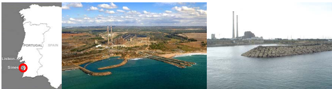
Figura 1: Sines. Visão geral da bacia de adução da central termoelétrica de Sines. Entrada da bacia de adução.
