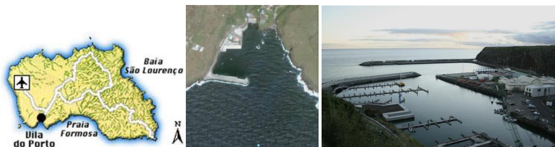
Figura 9 – Ilha de Santa Maria. Foto aérea da zona do porto antes da construção do núcleo de recreio. Foto do novo núcleo de recreio.
