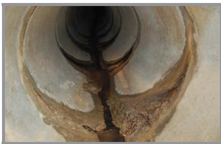
Figura 3.35 – Infiltração
