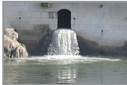
Figura 3.30 – Descarga de sistema unitário
