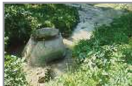
Figura 3.36 – Entrada em carga com extravasamento
