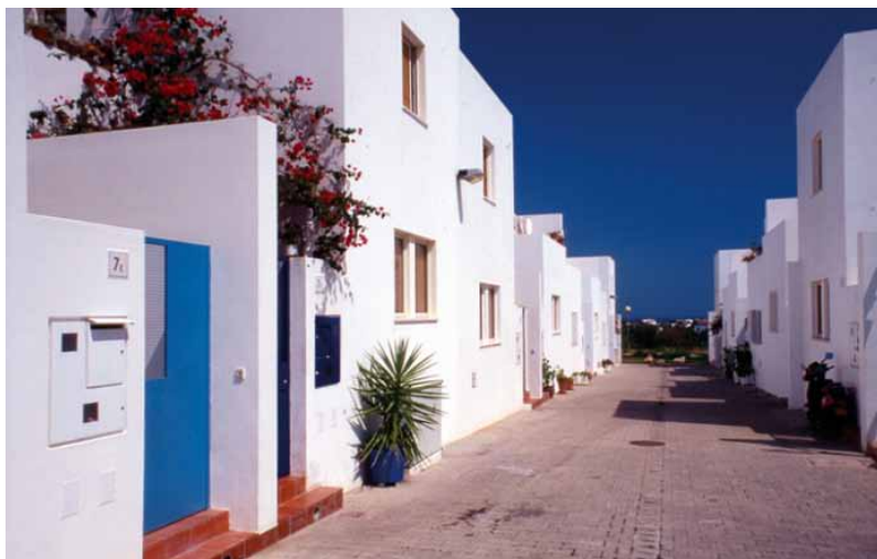
—Cooperativa O Nosso Piso, Conceição de Tavira, 1992, Arquitecto Pedro Serra Alves (GAR de Tavira)—
