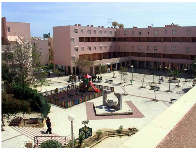
—Cooperativa de Habitação Económica Farenses, Coobital, Faro, Alto de Santo António, 1991, Arquitectos José Lopes da Costa e José Brito—
