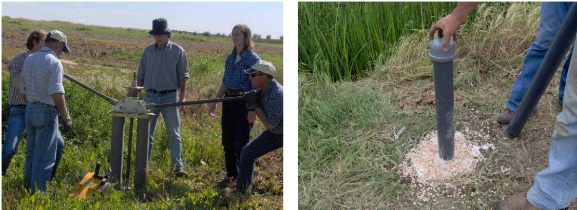
Fig. 19 - Instalação dos piezómetros
