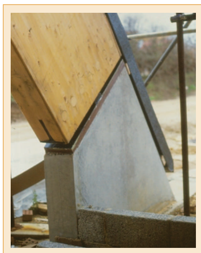
Figura 1: Apoio de pilar sobre sapata de betão com ventilação e capeamento metálico do extradorso exposto.
