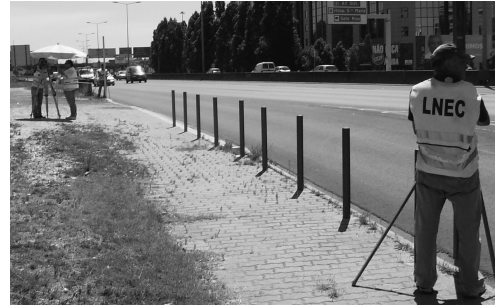
Figura 3 – Medição do desnível entre uma marca de passagem e a marca 512L14, situada na 2ª Circular
