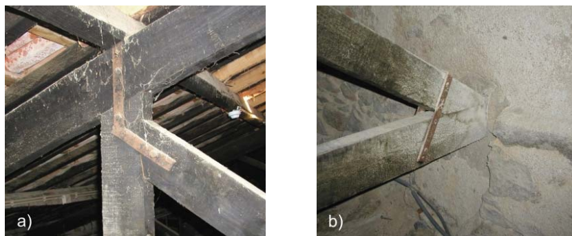
Figura 2.4 - Ligações com ferragens: a) esquadro; b) braçadeira
