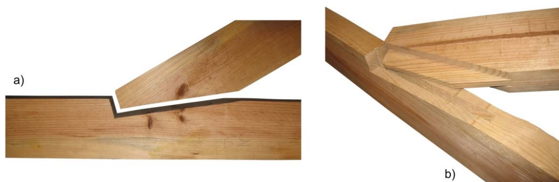
Figura 2.3 - Ligações tradicionais sem ferragens: a) ligação com dente simples; b) ligação com respiga e mecha
