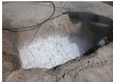
Fig. 21, Extinção da cal por aspersão
