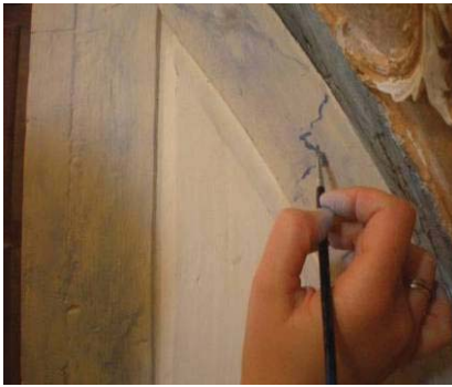
Fig. 160, Execução de um marmoreado de uma igreja, Àgueda (Obra IN SITU).
