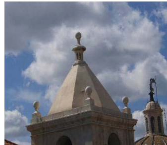
Fig. 227, Reboco de cal, Cúpula da Sé Nova de Coimbra (obra e foto IN SITU)
