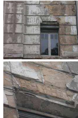
Fig. 66, Pormenor do revestimento, apresentando destacamentos, Lisboa
