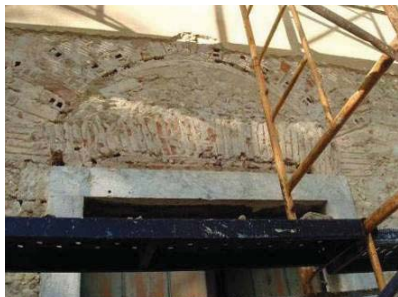
Fig. 171, Surgimento de arcos arredondado na antiga estrutura do edifício, Hospital Miguel Bombarda, Lisboa.
