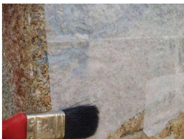
Fig. 380, Protecção do revestimento através de um facing
