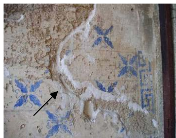
Fig. 381, Selagem das bordas, de zonas ocas, com Argamassa de cal
