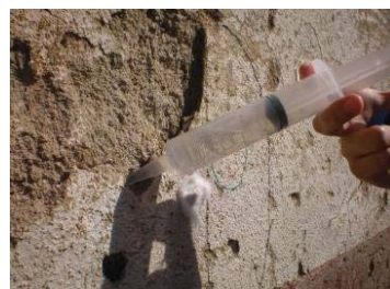
Fig. 378, Humedecimento dos vazios com Água + Álcool
