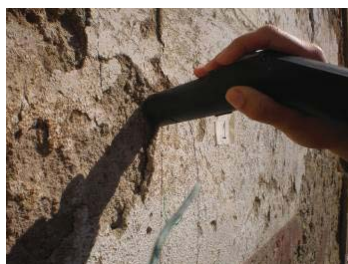
Fig. 377, Limpeza com aspirador de pó, antes da consolidação
