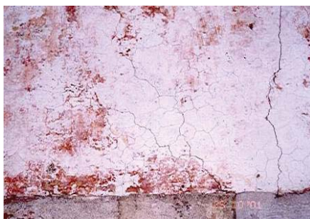
Fig. 199, Fissuras no revestimento
