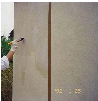
Fig. 430, Aplicação das caiações nos muretes
