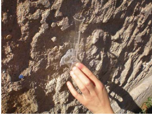
Fig. 368, Ensaio de tubos de Karsten sobre o reboco antigo
