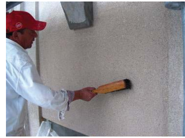
Fig. 92, Passagem da escova, para remoção da leitança de cal da fachada do Edifício Principal do LNEC
