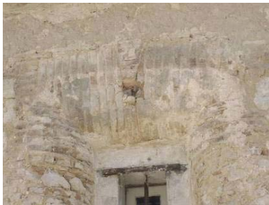
Fig. 169, Prospecção de um revestimento; nota-se a alvenaria antiga com forma arredondada, Hospital Miguel Bombarda, Lisboa.
