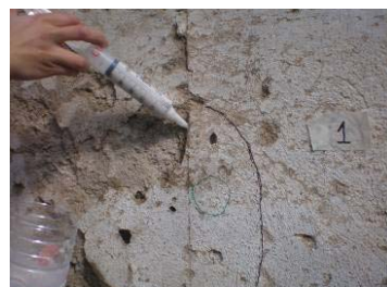
Fig. 379, Aplicação da Calda de cal com injeção manual
