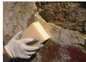
Fig. 376, Limpeza com esponja, antes da consolidação
