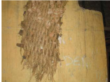
Fig. 13. Revestimento em terra e palha, Vinhais
