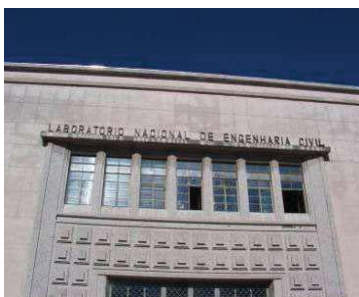
Fig. 78, Fachada do Edifício Principal do LNEC revestida a marmorite.
