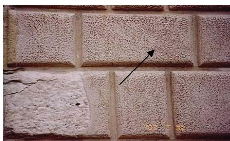
Fig. 41, Soco com acabamento picado, Convento de Cristo, Tomar
