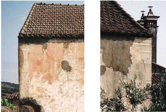
Fig. 159, Pintura fingindo cunhal, Idanha-a-Velha
