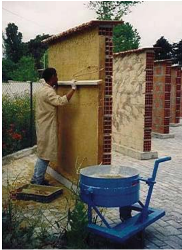
Fig. 25, Aplicação da camada de reboco
