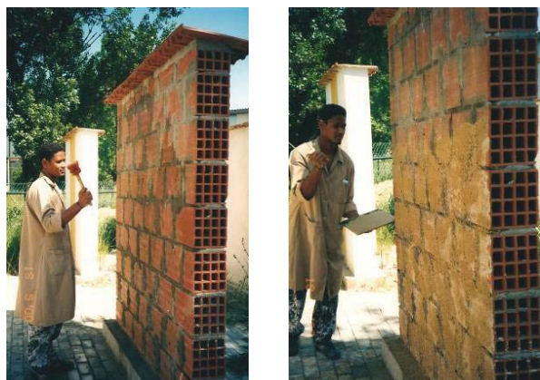
Fig. 24. Preparo da camada de emboço
