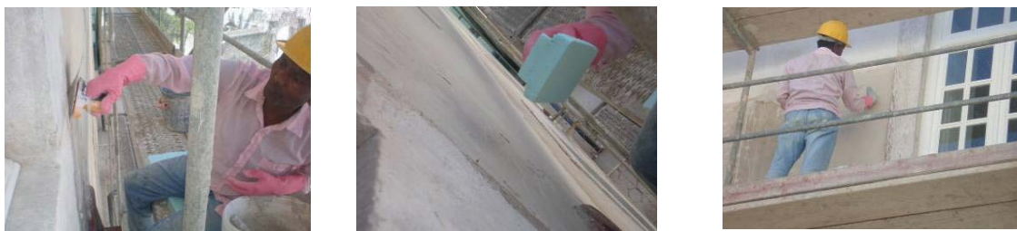
Fig. 31, A aplicação de barramento; observa-se a fina espessura da camada, Conventos dos Inglesinhos, Lisboa (Obra EDIFER)
