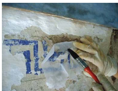
Fig. 247, Fixação da camada pictórica através da técnica do facing com Acril
