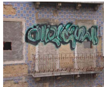
Fig. 104, Graffiti num edifício antigo em Lisboa
