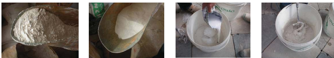
Fig. 32, Materiais utilizados para a execução de um barramento, Palácio de Belém, Lisboa (Obra IN SITU)
