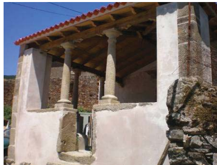
Fig. 35, Acabamento estanhado, Capela Velha, Castanheira de Pêra (Obra IN SITU)
