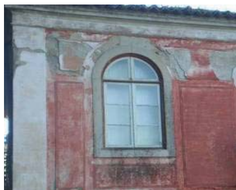
Fig. 121, Cornija em argamassa, Sintra
