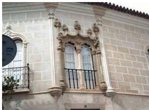
Fig. 48, Acabamento fingido pedra sobre o paramento exterior da Casa Garcia Resende, Évora
