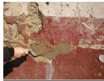
Fig. 382, Selagem de lacuna com Argamasa de cal e areia
