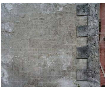
Fig. 100, Perda total da última camada de acabamento fingido, Sintra
