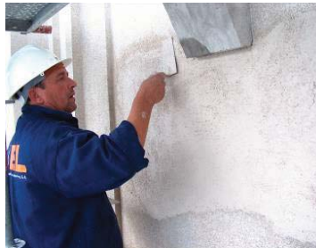
Fig. 91, Nivelamento do revestimento da fachada do Edifício Principal do LNEC
