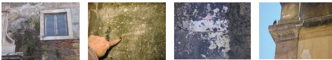
Fig. 196, Diversas formas de biodeterioração sobre os revestimentos
