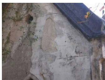
Fig. 69, Revestimento contínuo fingindo pedra, Sintra
