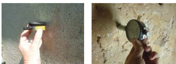
Fig. 367 , Ensaio com Durómetro, modelo SHORE A sobre argamassa do murete
