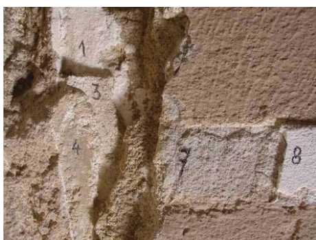
Fig. 173, Identificação estratigráfica das diversas camadas de revestimento, Sé de Évora
