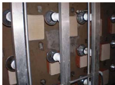
Fig. 268, Aplicação da primeira camada de argamassa
