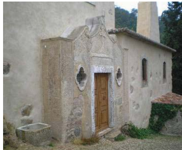
Fig. 226, Reboco de cal num edifício, Sintra (foto IN SITU)
