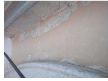
Fig. 213, Obturação de uma lacuna com argamassa de restauro, antes da reintegração cromática, Edifício do Lidador, Beja
