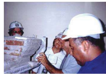
Fig. 128, A execução de cornijas com moldes (In www.ceci-br.org )
