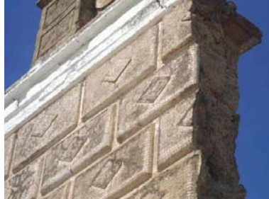
Fig. 77 , Fingido de pedra, provavelmente executados com moldes prefabricados, Castelo de Moura
