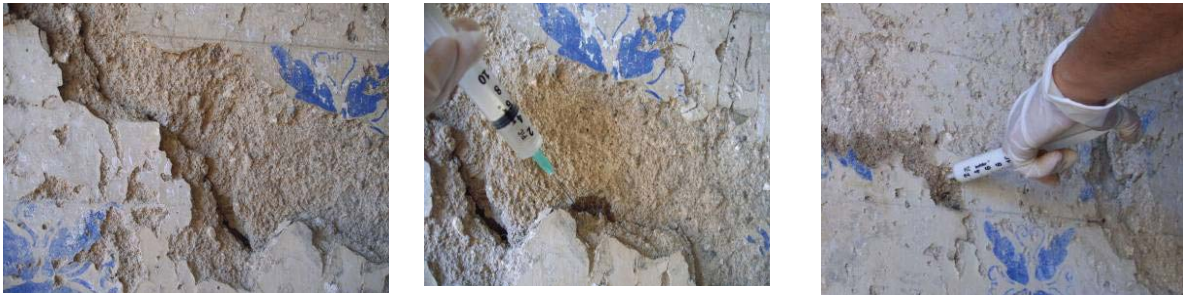
Fig. 385, Consolidação da perda de aderência através de injeção manual. Revestimeto fingido azulejo, Castanheira de Pêra (Foto IN SITU)
