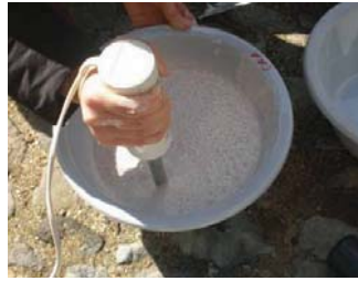
Fig. 373, Calda de cal misturada em obra com “varinha mágica”
