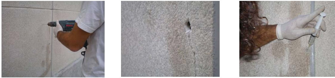
Fig. 383, Abertura de orifícios e humedecimento das zonas com vazios (Marmorite) fachada do Edifício Principal do LNEC
