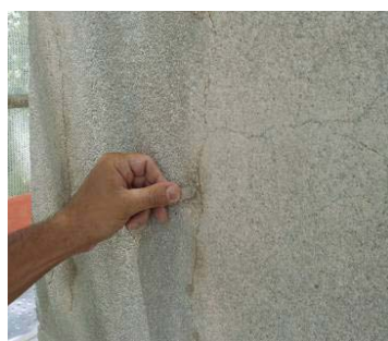
Fig. 209, Obturação das microfissuras (restauro da fachada do Edifício Principal do LNEC)
