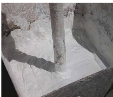
Fig. 27. A mistura da cal em pasta em obra, Convento dos Inglesinhos (Obra EDIFER)
