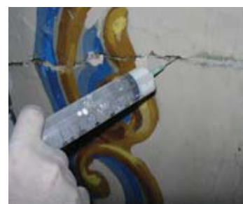
Fig. 248, Consolidação localizada em pequenas fissuras com o Acril
