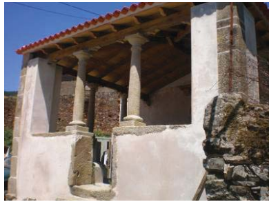
Fig. 225, Reboco de cal, Castanheira de Pêra (Obra e foto IN SITU)
