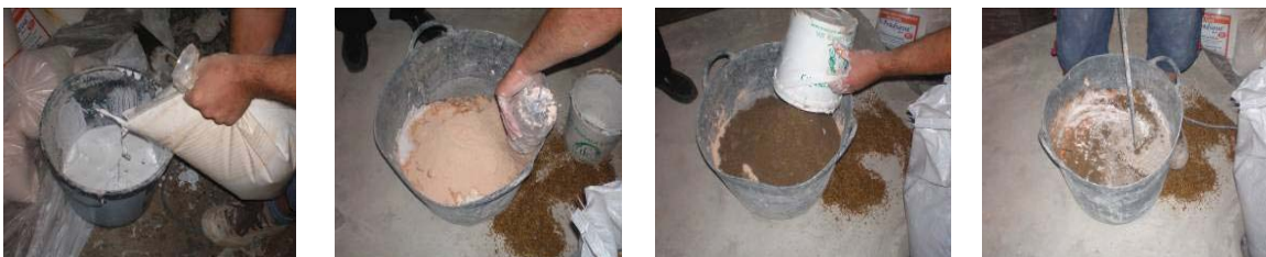
Fig. 221, Preparação em obra de uma argamassa de substituição de cal e pozolana (Argamassa Fradical), Rua do Alecrim, Lisboa
