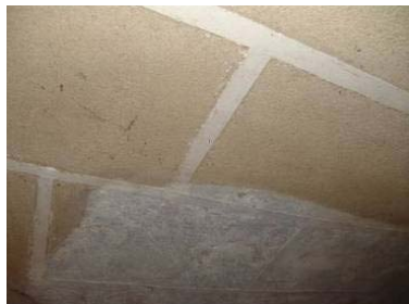
Fig. 57, Acabamento fingindo pilastral, Cabeço de Videl
