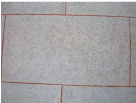
Fig. 217, Revestimento após o restauro: aplicação de argamassa de cal e pintura de fingido, Edifício do Lidador, Beja (Obra e foto IN SITU)
