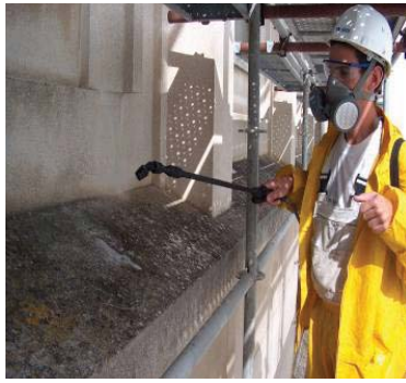
Fig. 203, Limpeza por via húmida, (restauro da fachada do Edifício Principal do LNEC).
