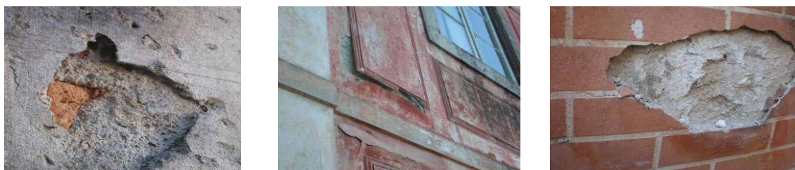
Fig. 370, A perda de aderência entre as camadas de reboco
