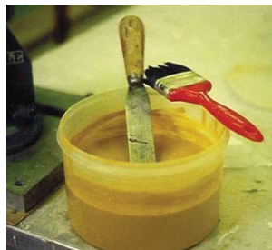
Fig. 425, A preparação do pigmento e a caiação de cal em pasta pigmentada pronta
