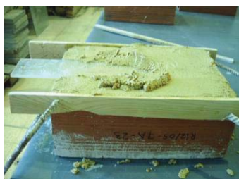
Fig. 400, A introdução de régua entre as camadas de argamassas
