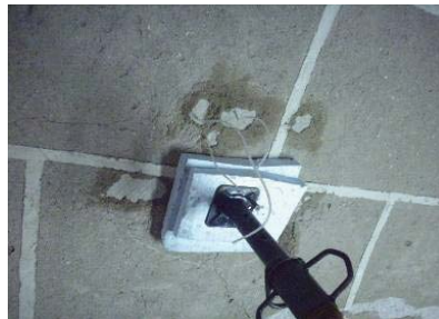
Fig. 386, Aplicação da injeção da Calda de cal e aplicação de um extensor para restabelecer a aderência, Igreja Espírito Santo, Arronches (Obra e foto IN SITU)
