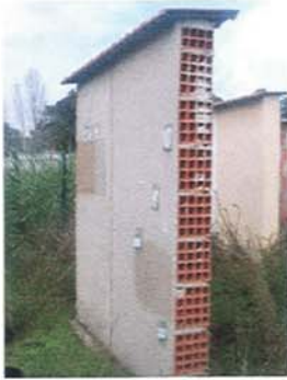
Fig. 255, Vista geral de um dos muretes
