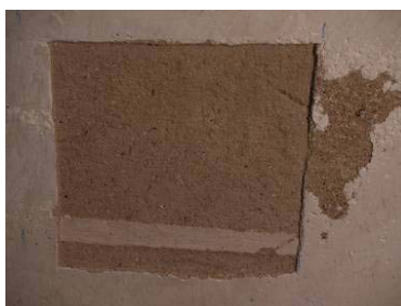
Remoção da repintura: descoberta de fingidos de pedra e esgrafitos
