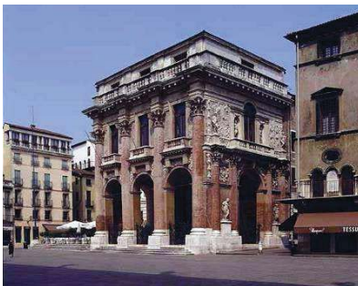
Fig. 42. Vista geral da Loggia de Capitanio em Vicenza; o uso de um revestimento imitando tijolo na fachada exterior do edifício (foto in www.cisapalladio.org )
