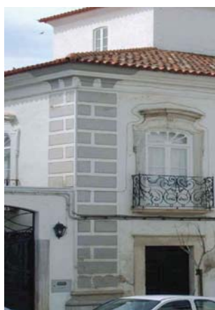
Fig. 148, Pintura fingindo um cunhal, Portel
