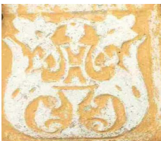
Fig. 106, Pormenor de um esgrafito num cunhal de um edifício em Évora.
