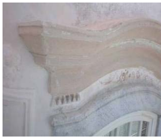
Fig. 214, Obturação de lacuna com argamassa de restauro, Edifício do Lidador, Beja
