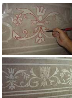
Fig. 218, Restauro de esgrafitos: execução de moldes, e o esgrafito após o restauro, Igreja Espírito Santo, Arronches (obra e foto IN SITU)
