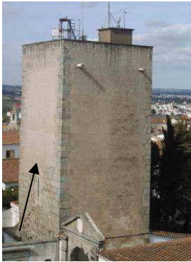
Fig. 49, Acabamento fingindo pedra cobrindo alvenaria exterior de um edifício na Freguesia da Sé, Évora
