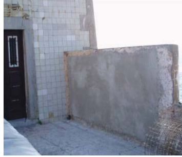
Fig. 223, Argamassa de cal aérea e cimento
