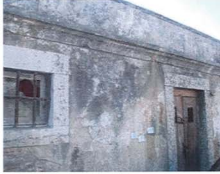
Fig. 256, Vista geral do edifício com o reboco antigo
