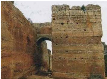
Fig. 12. Construção em taipa, Castelo de Paderne
