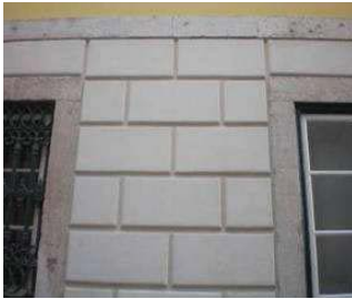
Fig. 61, Acabamento fingindo pedra no embasamento de um edifício em Lisboa
