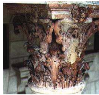
Fig. 44. Pormenor de um capitel com um acabamento de cal de fingido de tijolo (foto in www.cisapalladio.org )
