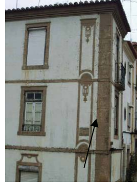
Fig. 56, Revestimento fingindo cunhal, Crato
