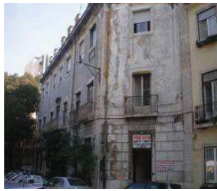
Fig. 62, Acabamento fingindo pedra, Praça da Alegria, Lisboa
