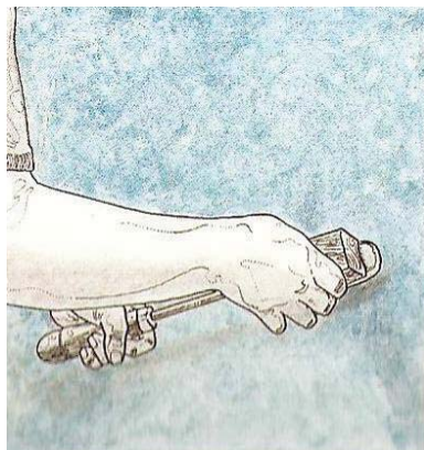
Fig. 37 , Colocação dos ferros no forno e a passagem do ferro sobre o revestimento (foto Guía El Estuco , 1998, p.114)
