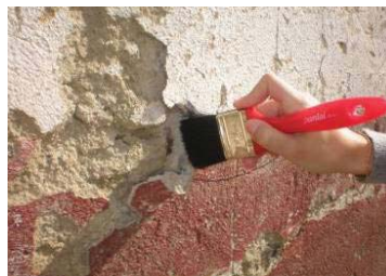
Fig. 375, Limpeza com trincha, antes da consolidação
