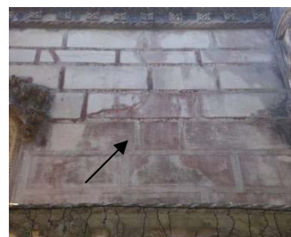
Fig. 73, Nota-se por baixo do actual acabamento um outro revestimento fingido, Quinta da Regaleira, Sintra
