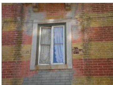
Fig. 96, Acabamento fingindo tijolo aplicado em faixa com duas cores, Colares, Sintra
