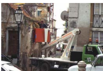
Fig. 182, Estratigrafia de revestimentos exteriores, Bairro do Castelo, Lisboa
