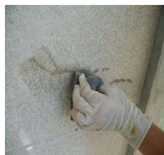
Fig. 210, Nivelamento da argamassa.
