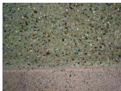
Fig. 82, Acabamento em marmorite com agregado de vidro, Palmela
