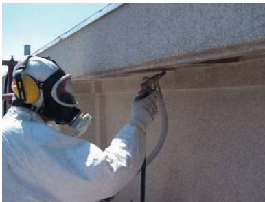
Fig. 205, Limpeza com micro abrasivos, (restauro da fachada do Edifício Principal do LNEC)
