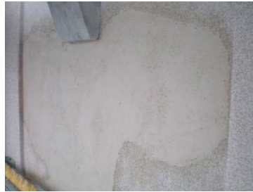
Fig. 212, A lacuna após preenchimento (restauro da fachada do Edifício Principal do LNEC)
