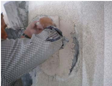
Fig. 90, Aplicação da marmorite numa lacuna na fachada do Edifício Principal do LNEC
