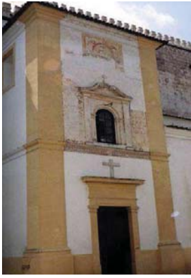
Fig. 164, Pintura mural na fachada exterior da Igreja de S. Francisco, Évora
