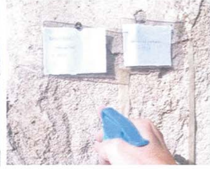
Fig. 257, Pormenor da consolidação sobre o reboco antigo
