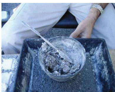
Fig. 208, Argamassa para obturação de microfissuras
