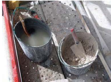
Fig. 88, A argamassa, antes da aplicação e água para lavagem
