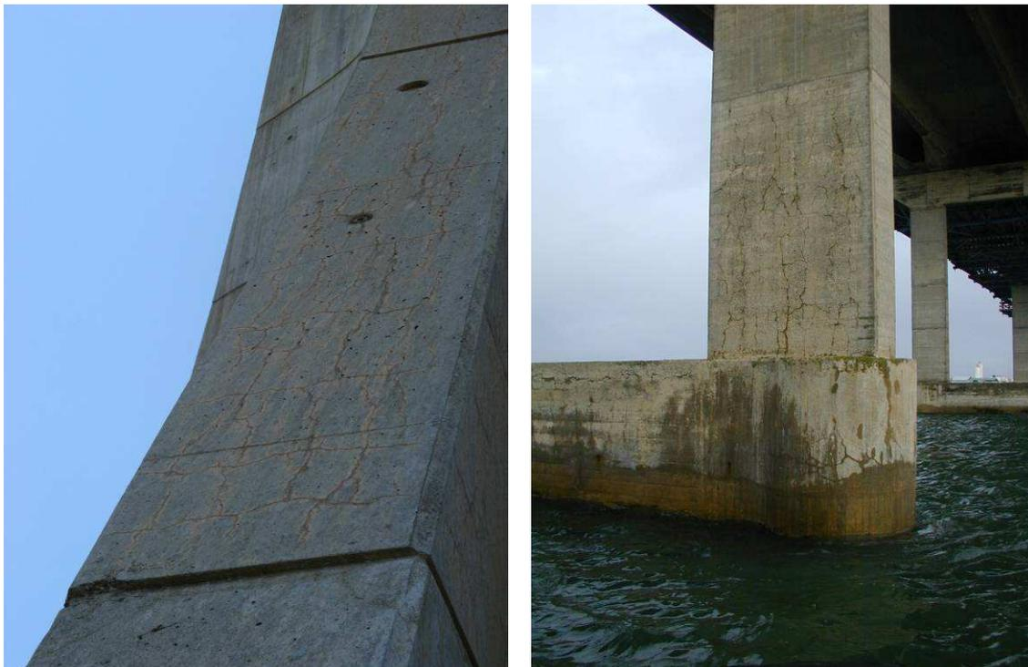
Figura 1 – Fissuração no betão característica de reacções expansivas internas.
