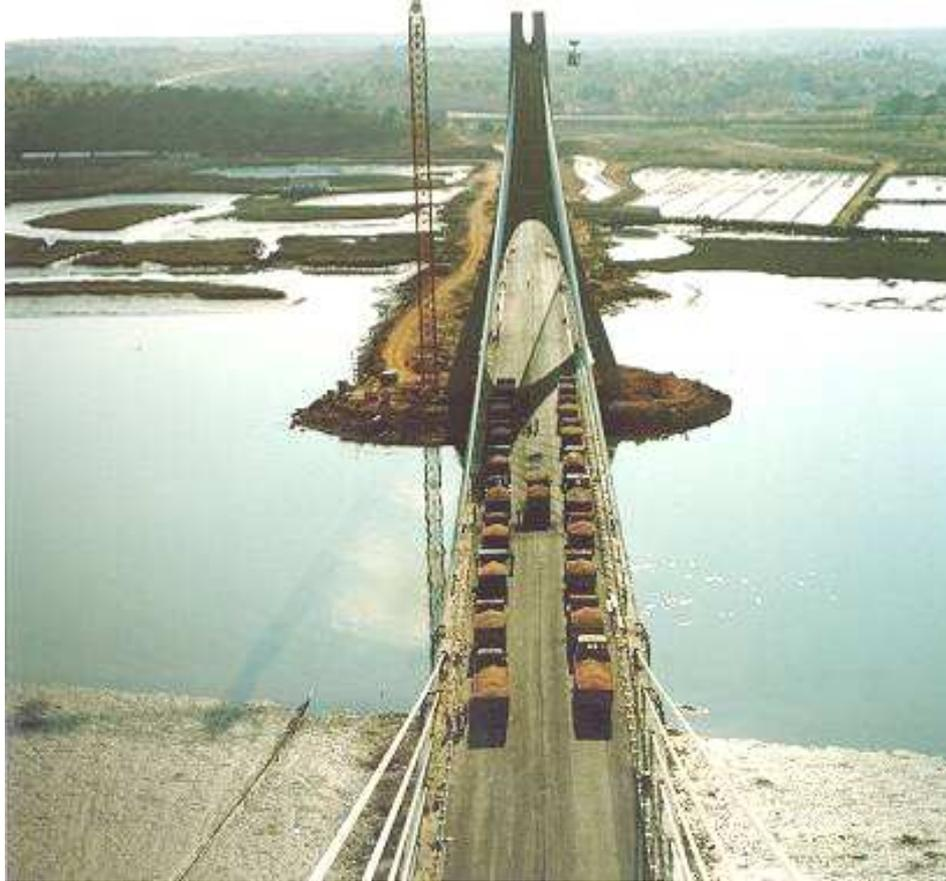
Figura 13 – Ensaio de carga da ponte do Arade [17]
