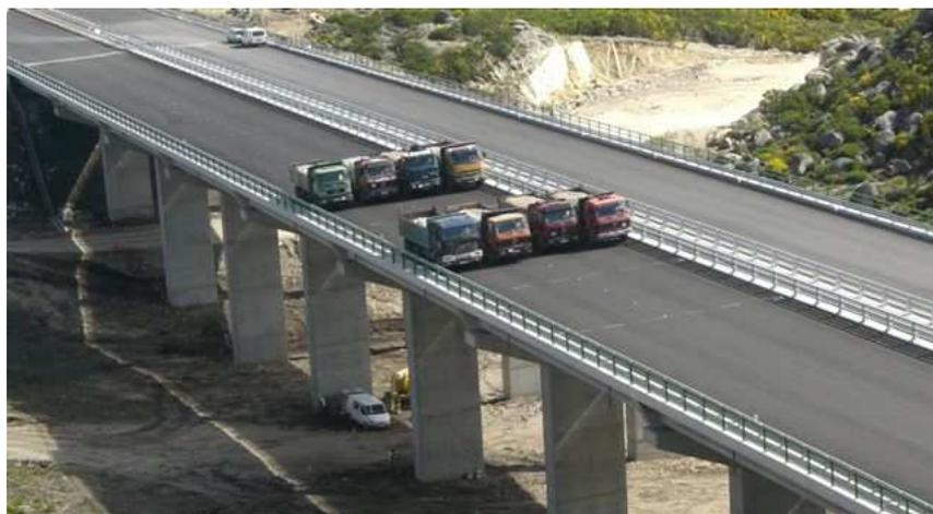
Figura 12 – Ensaio de recepção em estruturas de vão corrente (A24)
