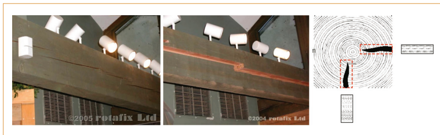
Colmatação de fendas com cunha de madeira colada [foto gentilmente cedida por Rotafix, Ltd].
