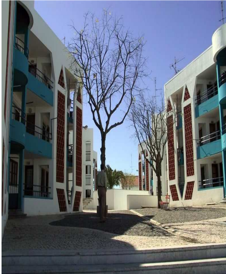
Fig. 03: e os bons exemplos de uma densificação urbana bem humanizada continuaram, tal como aqui na agradável e bem integrada Unidade Residencial João Barbeiro, em Beja, projecto dos arquitectos Raul Hestnes Ferreira e Manuel Miranda, cerca de 1984.
