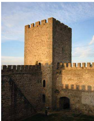
Fig. 1 – Castelo de Amieira do Tejo, em alvenaria de pedra com argamassa de cal
