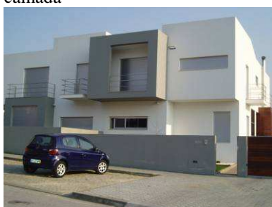
Fig. 5 – Revestimento exterior do tipo ETICS
