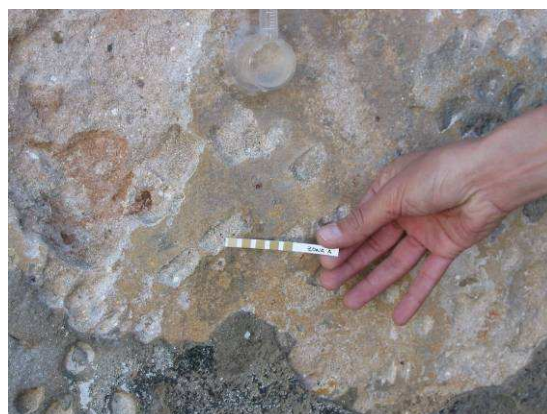
Fig. 29 – Erosão de reboco antigo
