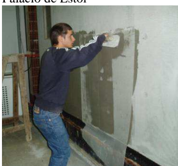
Fig. 7 – Aplicação de rede de fibra de vidro entre camadas de argamassa em ETICS
