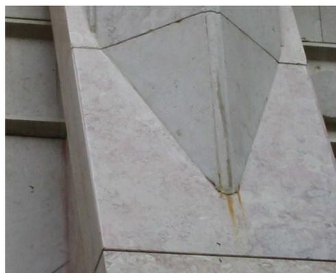
Figura 4: Oxidação de peças metálicas
