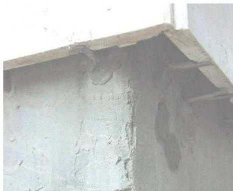
Figura 2: Pedras destacadas em revestimentos de fixação indirecta.
