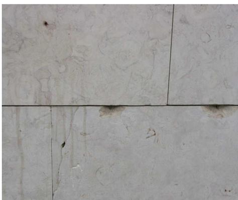
Figura 3: Rotura de pedras nos pontos de inserção dos gatos e fissuras
