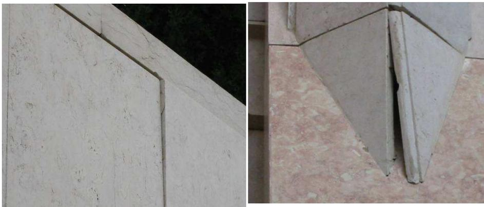
Figuras 5 e 6: Destacamentos de placas e falta de gatos
