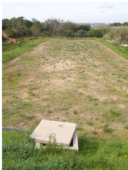
Fig. 9 - Leito filtrante da bacia designada BTA ao km 40+200 da A22/IC4, Alcantarilha – Guia
