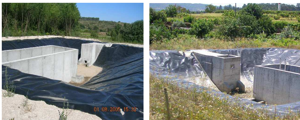
Fig. 12 - Alteração do posicionamento do órgão de descarga da bacia, após obras de reabilitação
