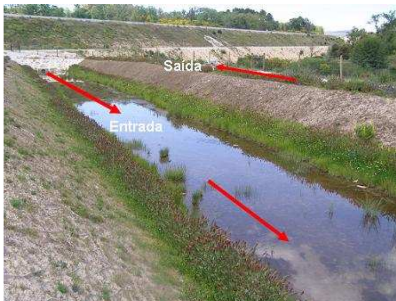
Fig. 18 - Aspecto da vala relvada da A24/IP3, EN103/Chaves (Fronteira) (8 de Maio de 2007)
