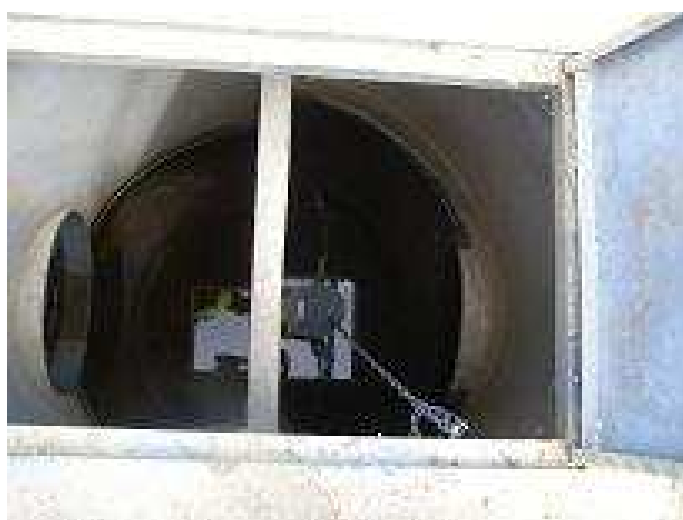
Fig. 19 - Caixa de visita à saída da vala relvada da A24/IP3, EN103/Chaves com válvula de fecho e controlo de óleos e gorduras
