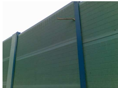
Fig. 63 - Exemplos de problemas de deficiente selagem
