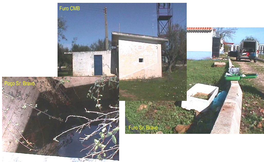
Fig. 37 - Locais de amostragem de águas subterrâneas junto à A6, nó de Borba (Leitão et al. , 2005)
