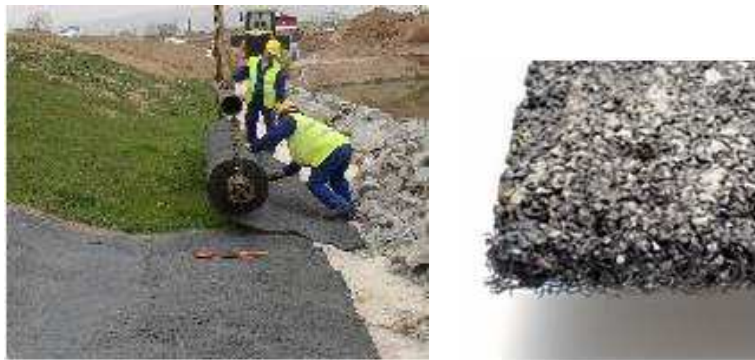
Fig. 3 - A66 entre Toulouse e Pamiers (fotografia de 2004). Utilização do Enkamat® A20
