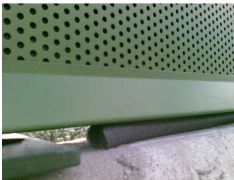
Fig. 63 - Exemplos de problemas de deficiente selagem
