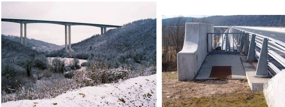
Fig. 2 - Exemplo de recolha de águas de escorrência ao longo de toda a extensão do viaduto, para protecção de um vale sensível. Após tratamento as escorrências são lançadas no ambiente de forma controlada
