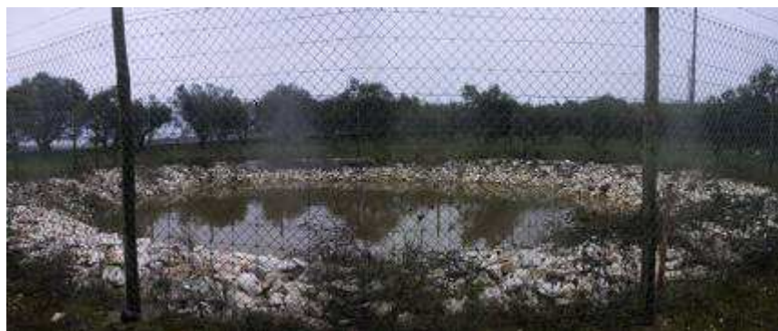
Fig. 8 - Foto de uma das 3 bacias da A6, que apresenta entradas de água sub-superficial e subterrânea (Janeiro de 2002)
