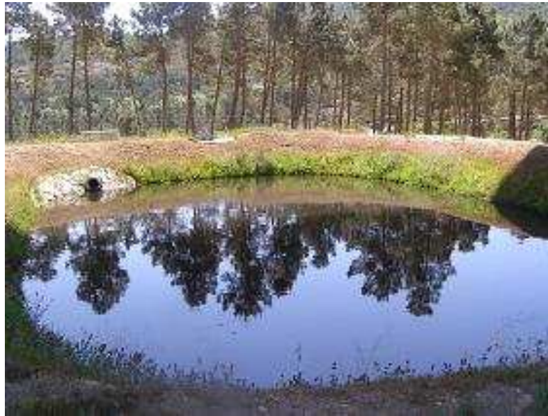
Fig. 16 - Bacia ao km 25+550, A24/IP3, Pedras Salgadas/EN103 (8 de Maio de 2007)
