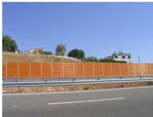
Fig. 69 - Exemplos de implantação geométrica barreira-receptor de reduzida eficácia
