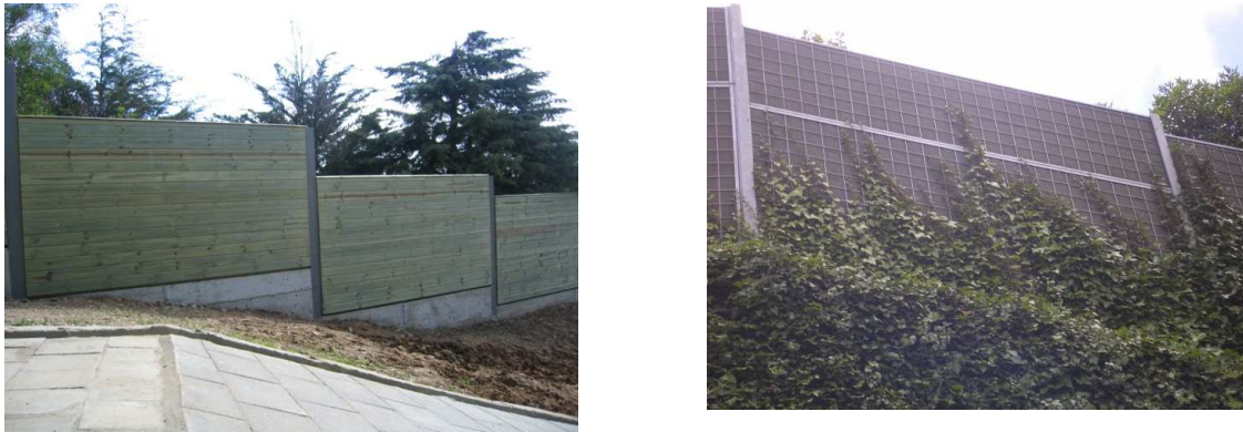
Fig. 65 - Exemplos de barreiras acústicas do tipo "natural"
