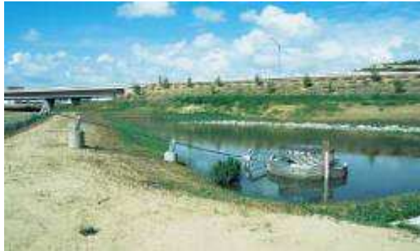
Bacia de detenção extensa
