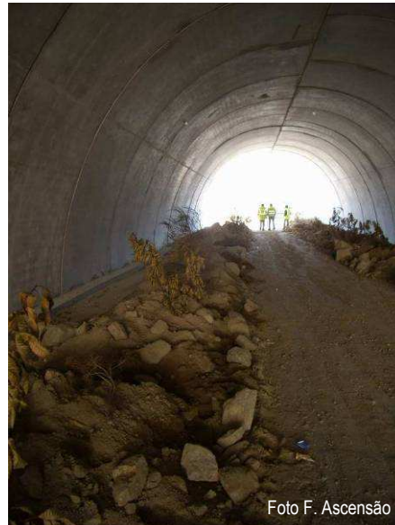
Fig. 73 - Passagem inferior na A24/IP3 – pormenor de material para abrigo de espécies mais pequenas
