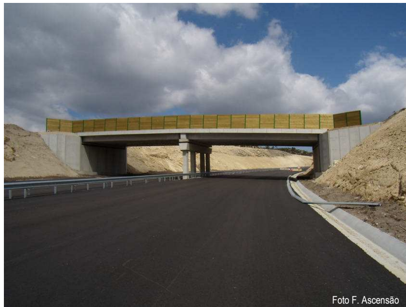
Fig. 70 - Passagem superior na A24/IP3
