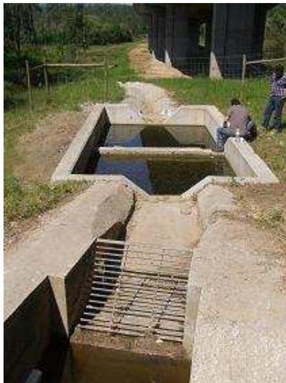
Fig. 24 - Aspecto do sistema localizado ao km 1+500 da A27/IP9, Nogueira-Estorãos em Maio de 2007. Medições com sonda multiparamétrica
