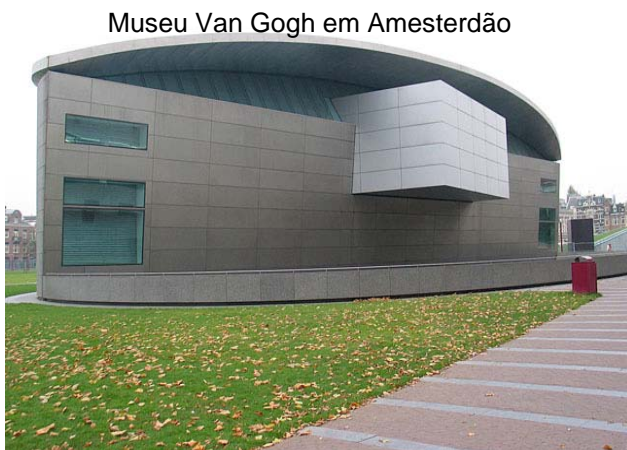
Figura 4: Exemplos de aplicação de titânio no revestimento de edifícios
