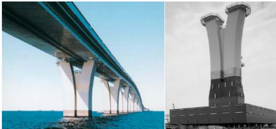
Figura 7: Pilares de aço revestidos a titânio. Trans-Tokyo Bay Highway [23]
