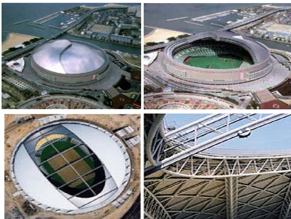
Figura 3: Aplicação de titânio no revestimento de coberturas móveis de estádios. Estádio Fukuoka (em cima). Estádio Oita - Big Eye (em baixo)
