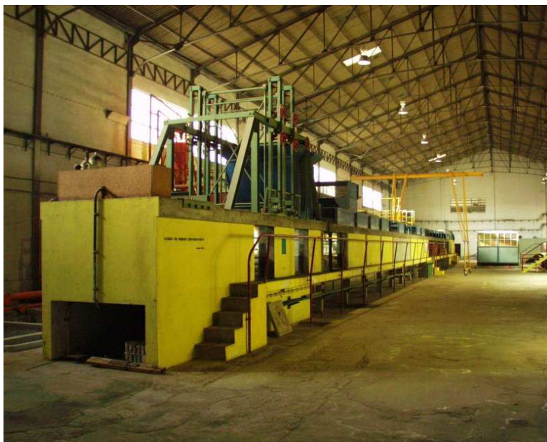
Figura 15 – Vista geral do COI1.
