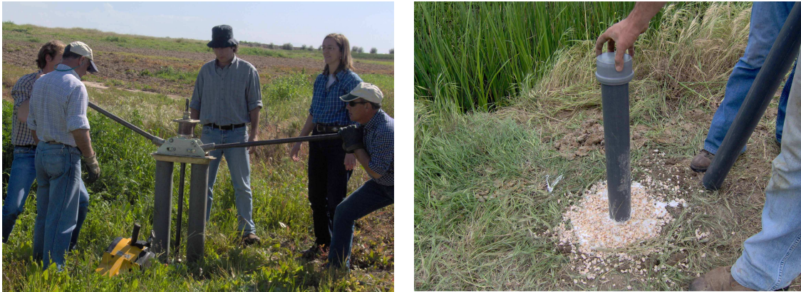
Fig. 13 - Instalação dos piezómetros
