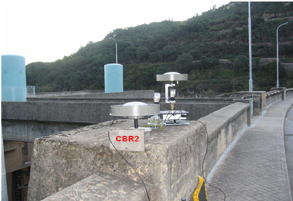
Figura 10 – Estação GNSS CBR, no coroamento da Barragem do Cabril, no lado de montante, junto à consola central.
