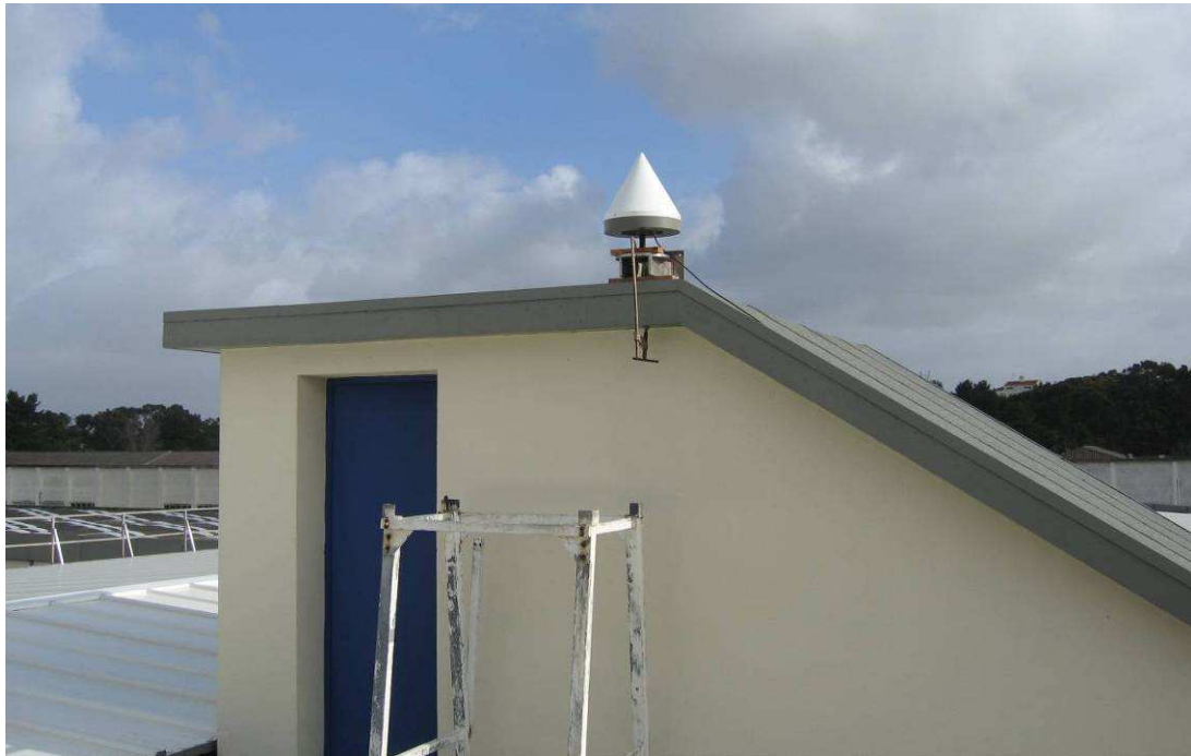
Figura 2 – Segunda estação GNSS, no edifício das Componentes (COMP).
