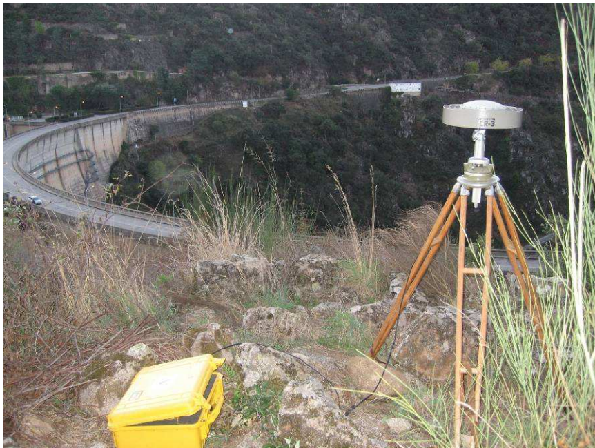
Figura 8 – Estação REF1, na margem direita da Barragem.
