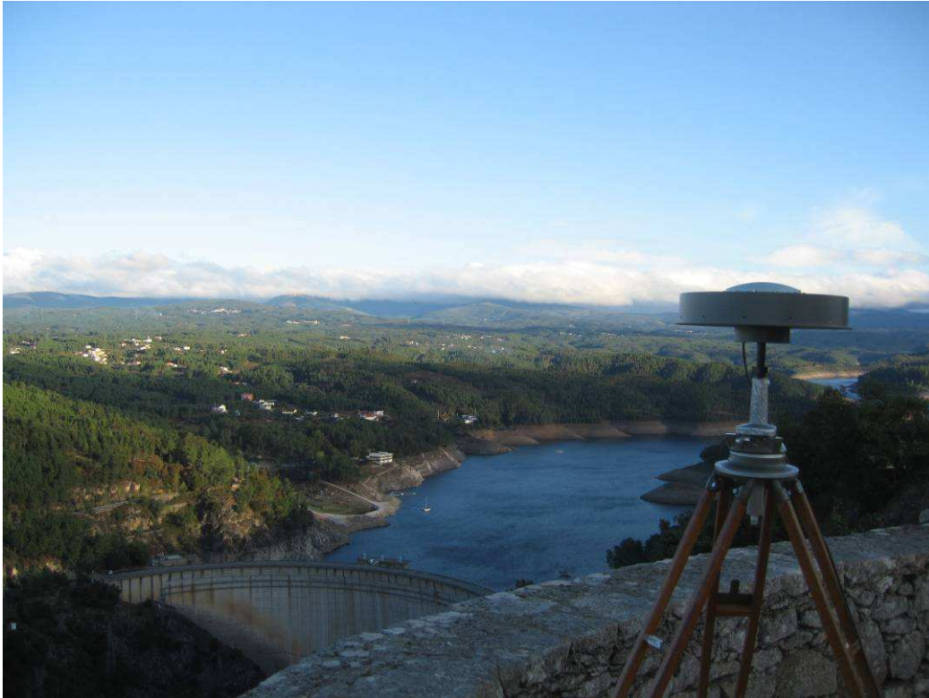
Figura 9 – Estação GNSS REF2, na margem esquerda da barragem, perto da Capela da Senhora da Confiança.
