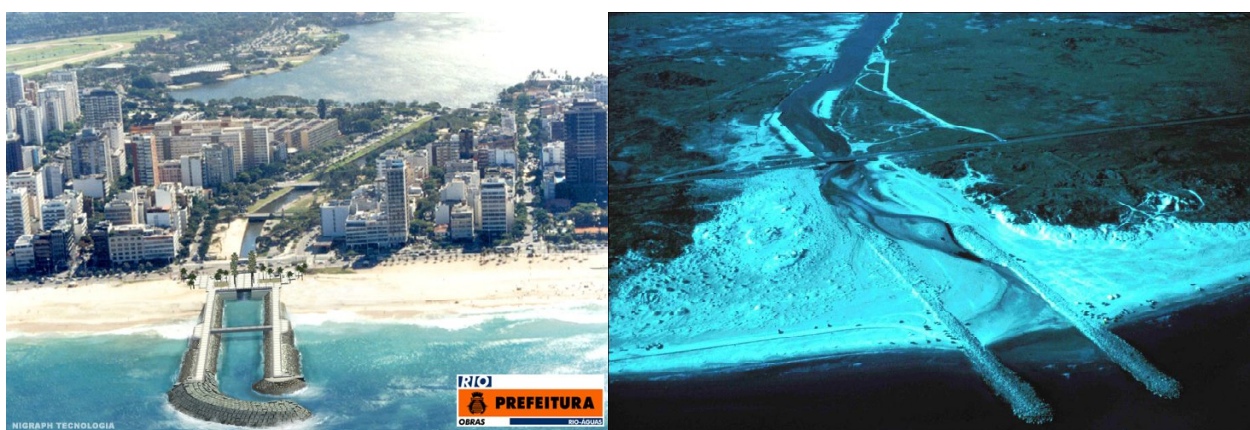
Figura 6 – Exemplos de aplicação de quebra-mares para estabilização de embocaduras: a) projecto para a Lagoa Rodrigo de Freitas, Brasil (cortesia da Fundação Rio Águas); b) Fish Pass, E.U.A. (Davies e Zarillo, 2003). Examples of the use of breakwaters to stabilize tidal inlets: a) Project for the Rodrigo de Freitas Lagoon, Brazil; b) Fish Pass, U.S.A. (Davies and Zarillo, 2003).
