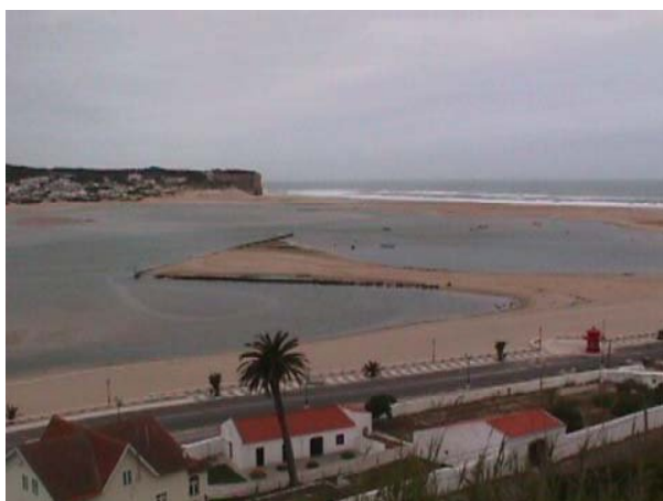
Figura 8 – Dique de guiamento junto à Foz do Arelho, Portugal. Guiding wall near Foz do Arelho, Portugal.
