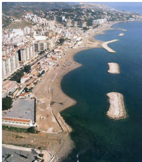
Figura 3 – Exemplo de quebra-mares destacados na praia de O Palo (Málaga - Espanha). Examples of detached breakwaters in the beach of O Palo (Málaga – Spain).
