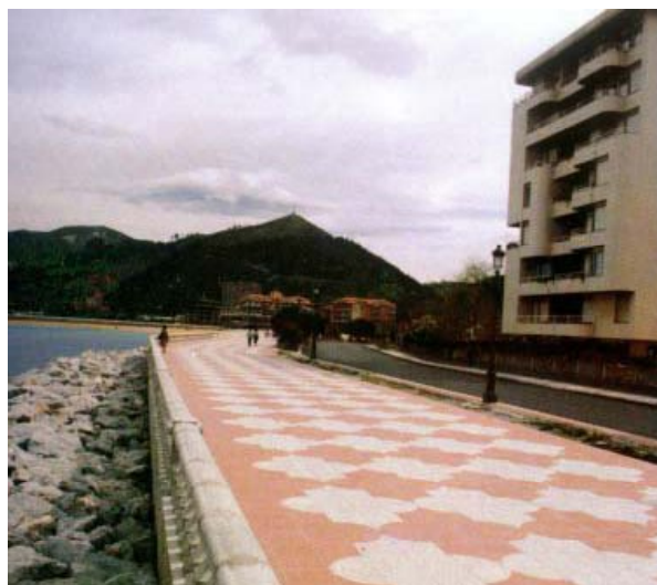
Figura 1 – Exemplo de defesa longitudinal aderente na praia de Castro Urdiales (Cantábria, Espanha). Example of longitudinal defence in the Castro Urdiales beach (Cantábria, Spain).
