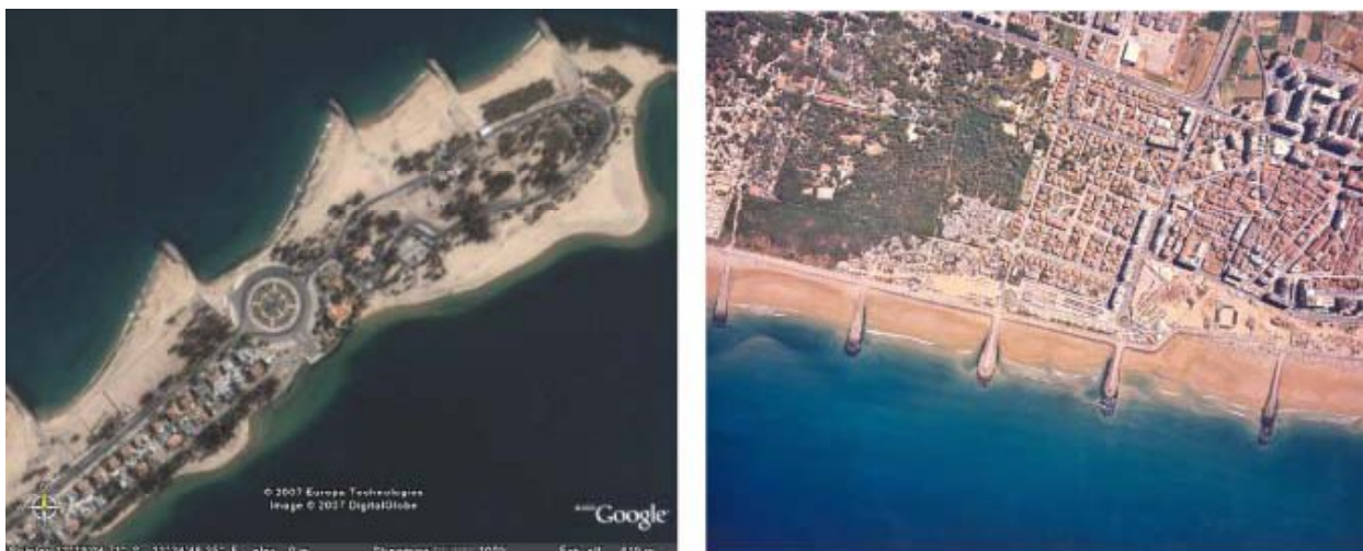
Figura 2 – Exemplos de campos de esporões: restinga do Lobito (Angola) e Costa de Caparica (Portugal). Examples of groin fields: Lobito sand spit (Angola) and Costa da Caparica (Portugal).
