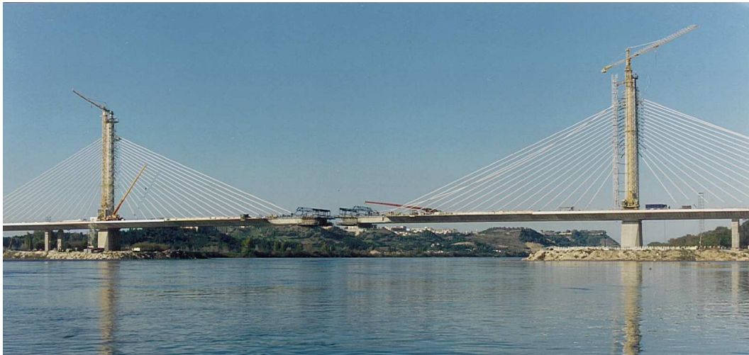
Figura 4.6 – Construção do tramo central pelo método de avanços sucessivos
