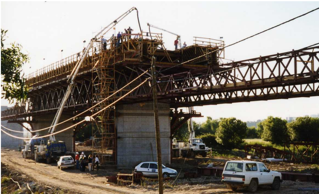
Figura 4.5 – Construção dos tramos laterais com viga de lançamento inferior
