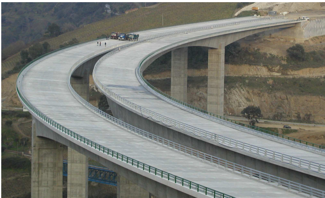
Figura 2.6 – Ensaio estático na Ponte sobre o rio Corgo para determinação de linhas de influência
