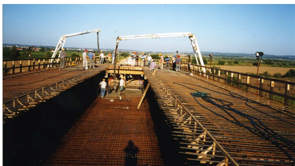
(b) 1ª fase de betonagem dos tramos laterais
