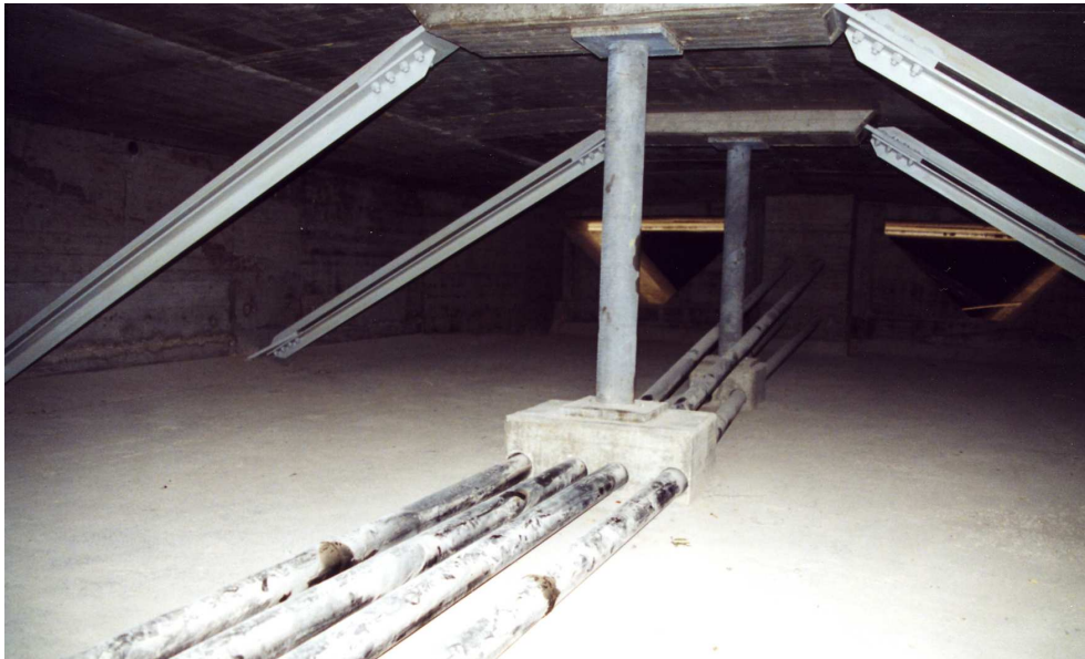
Figura 4.4 – Montantes metálicos e pré-esforço exterior nos tramos extremos
