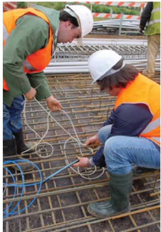
(b) colocação do sensor (Matos et al , 2005)
