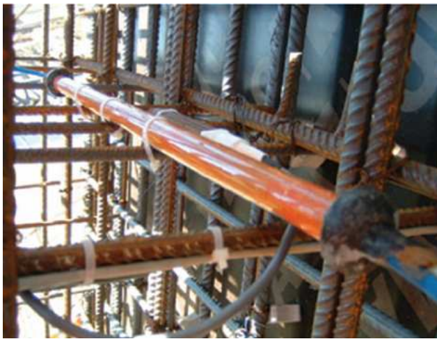
(a) sensor de fibra óptica (Matos et al , 2005)
