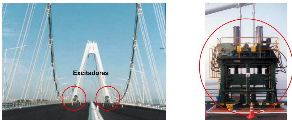
Figura 2.7 – Ensaio de vibração forçada na Ponte de Yeongjong, na Coreia do Sul (Rodrigues, 2004)
