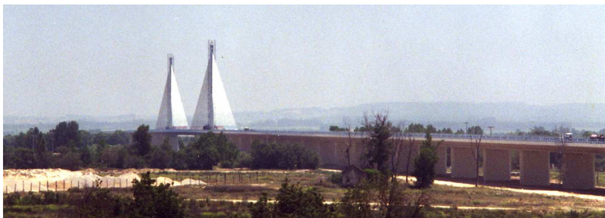
Figura 4.1 – Vista Geral da Ponte Salgueiro Maia
