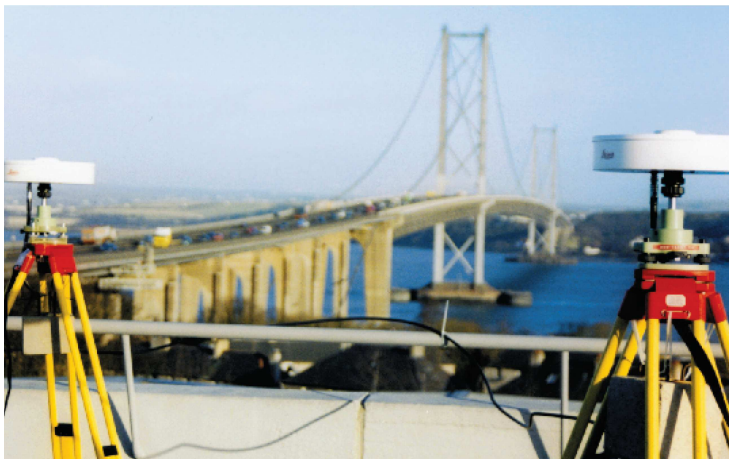
(a) Receptores de referência instalados junto à ponte
