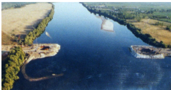
(a) Fundações dos pilares P4 e P5
