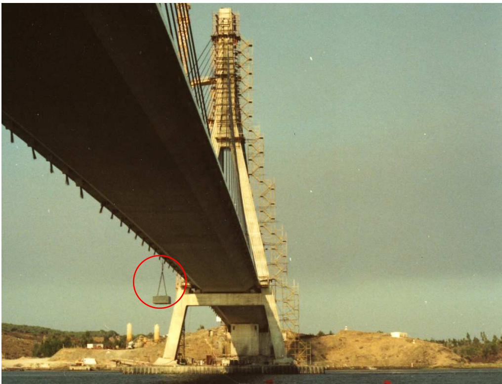
Figura 2.8 – Massa usada nos ensaios dinâmicos de vibração em regime livre na Ponte do Guadiana
