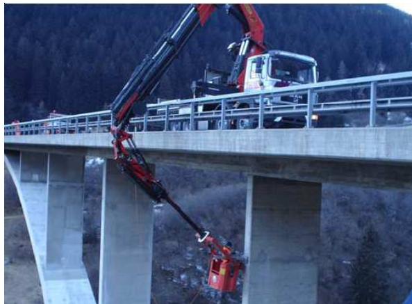
(a) Instalação de um painel solar
