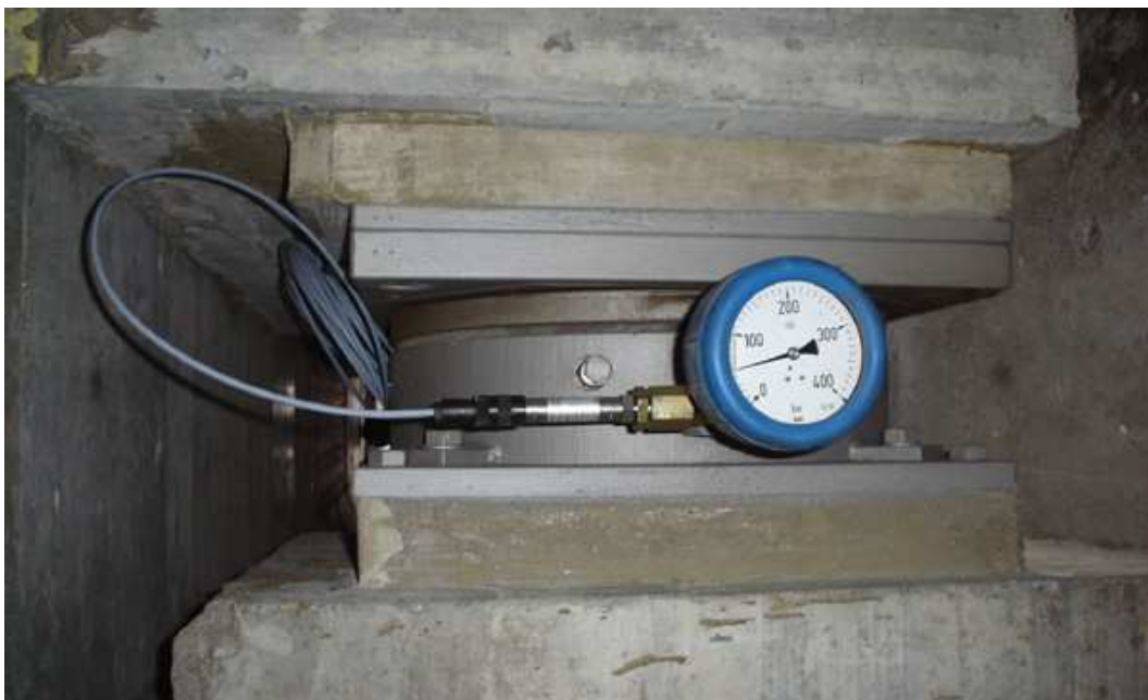
Figura 2.24 – Aparelho de apoio com sistema de medição de força (Mageba, 2007)
