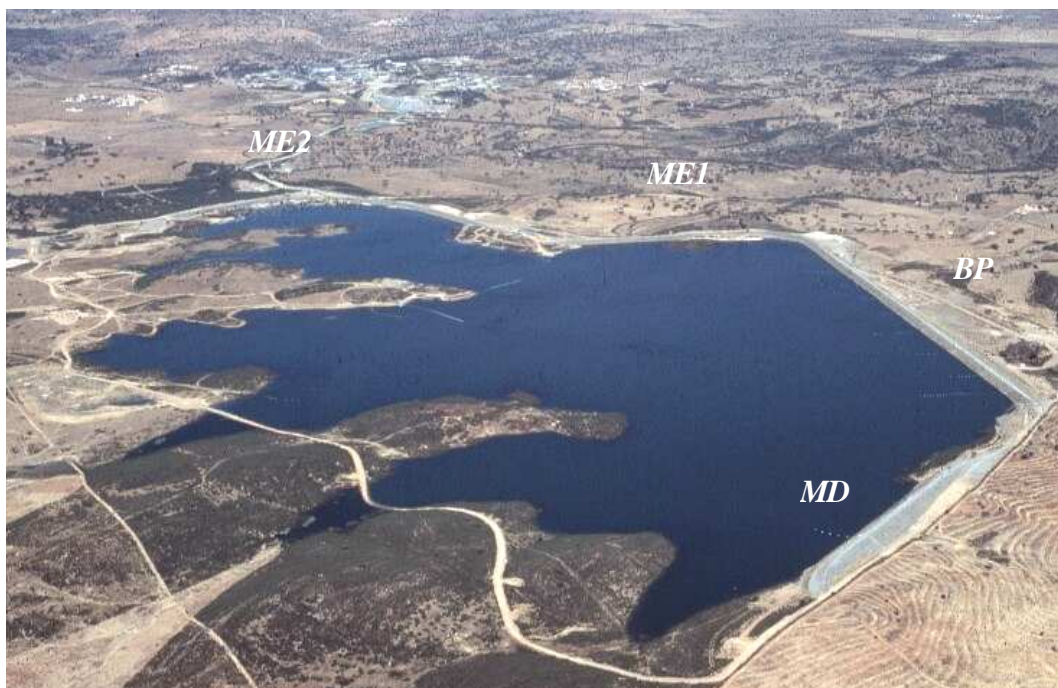
Figura 7.1 – Fotografia aérea da barragem de Cerro do Lobo (cedida pela SOMINCOR)
