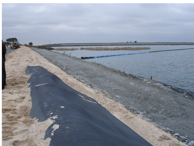
Figura 7.9 – Construção do último alteamento. Zona do coroamento da geomembrana e sua camada superior para protecção contra o punçoamento
